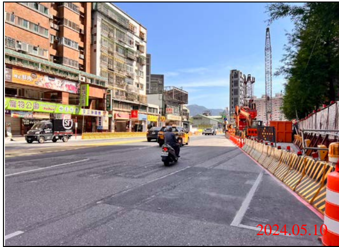
巡查日期地點：113.05.10/ Y22車站 照片說明：路面狀況
