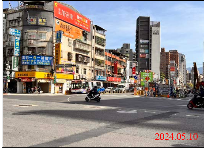
巡查日期地點：113.05.10/ Y21車站 照片說明：路面狀況
