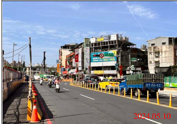
巡查日期地點：113.05.10/ Y21車站 照片說明：路面狀況
