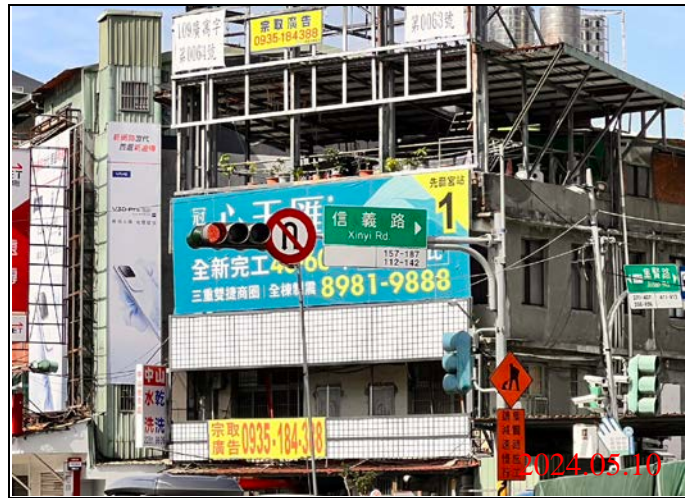
巡查日期地點：113.05.10/ Y21車站 照片說明：牌面設置狀況
