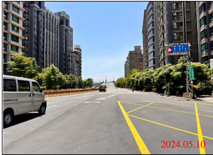
巡查日期地點：113.05.10/ Y23車站 照片說明：路面狀況
