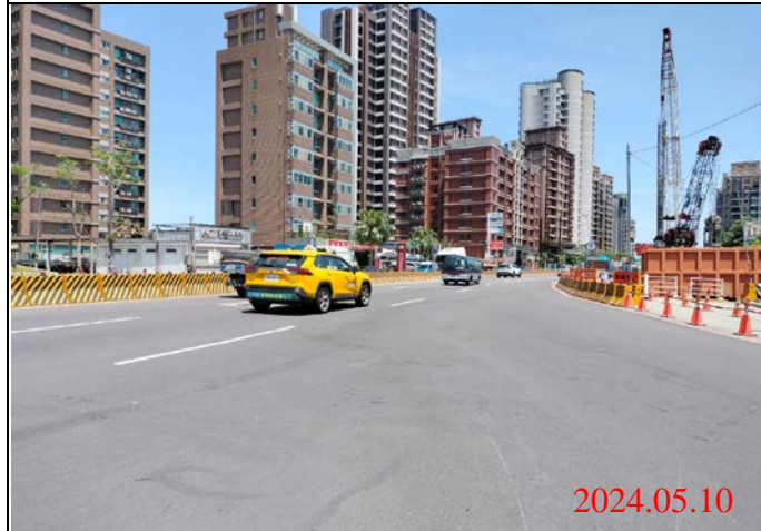
巡查日期地點：113.05.10/ Y23車站 照片說明：路面狀況
