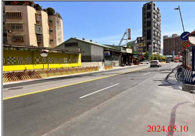
巡查日期地點：113.05.10/ Y22車站 照片說明：路面狀況
