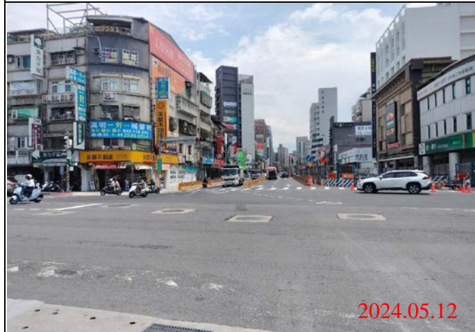
巡查日期地點：113.05.12/ Y21車站 照片說明：路面狀況
