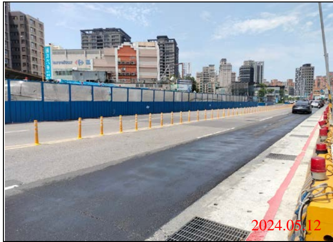
巡查日期地點：113.05.12/ Y22車站 照片說明：路面狀況
