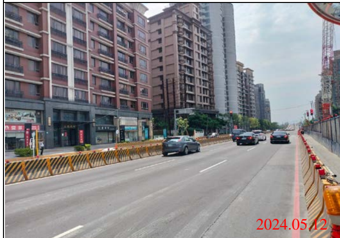
巡查日期地點：113.05.12/ Y23車站 照片說明：路面狀況
