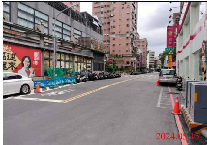
巡查日期地點：113.05.15/ Y21車站 照片說明：路面狀況
