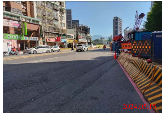
巡查日期地點：113.05.15/ Y22車站 照片說明：路面狀況
