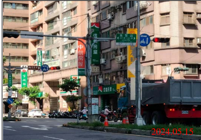
巡查日期地點：113.05.15/ Y22車站 照片說明：牌面設置狀況
