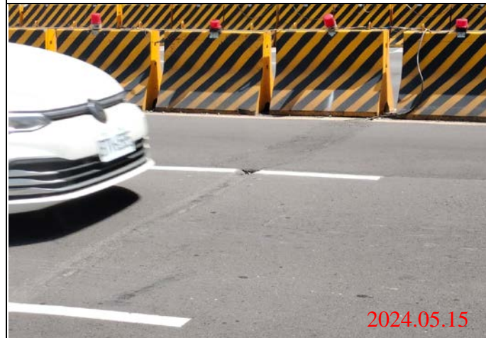
巡查日期地點：113.05.15/ Y23車站 照片說明：南側道路坑洞
