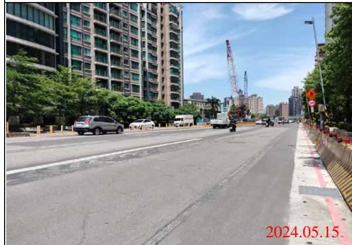
巡查日期地點：113.05.15/ Y23車站 照片說明：路面狀況
