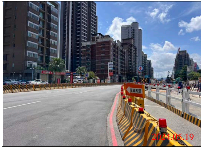
巡查日期地點：113.05.19/ Y23車站 照片說明：路面狀況
