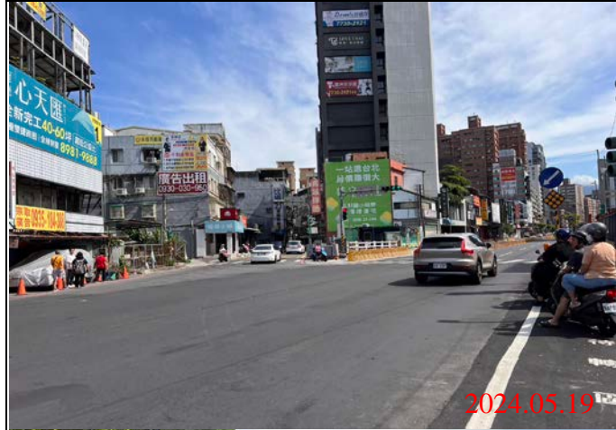
巡查日期地點：113.05.19/ Y21車站 照片說明：路面狀況
