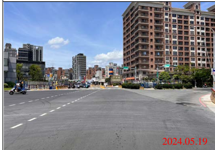
巡查日期地點：113.05.19/ Y22車站 照片說明：路面狀況
