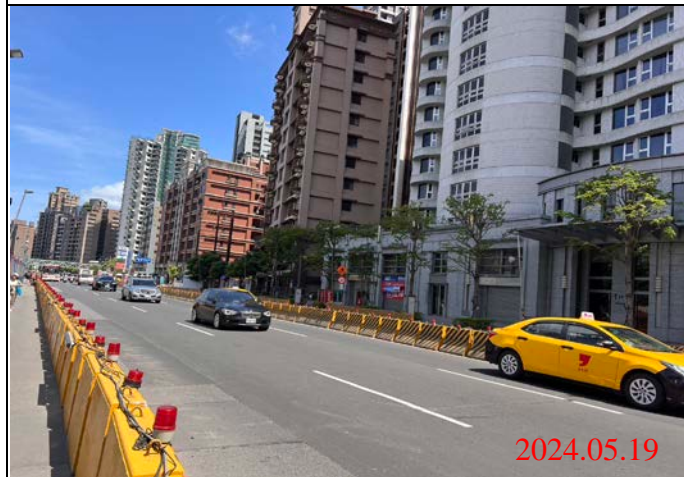
巡查日期地點：113.05.19/ Y23車站 照片說明：路面狀況
