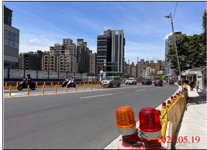
巡查日期地點：113.05.19/ Y22車站 照片說明：路面狀況
