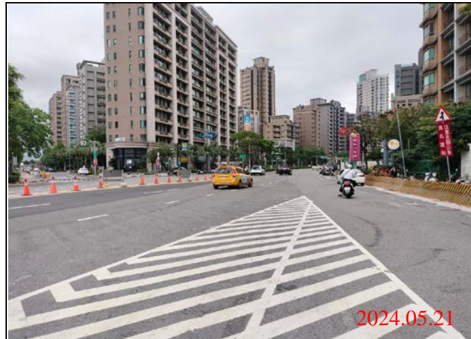
巡查日期地點：113.05.21/ Y22車站 照片說明：路面狀況
