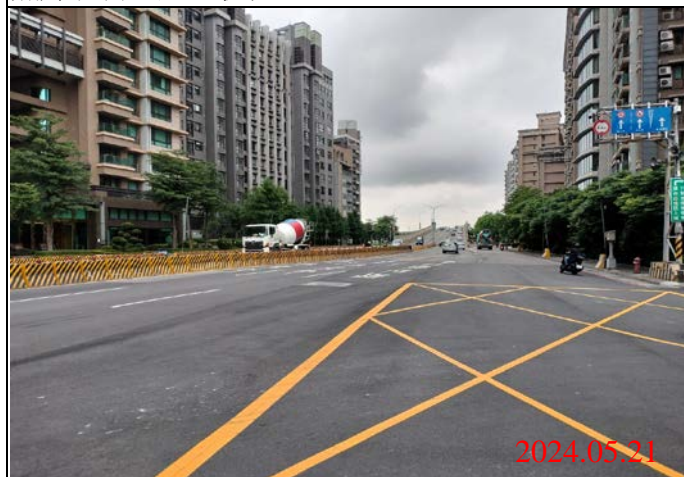
巡查日期地點：113.05.21/ Y23車站 照片說明：路面狀況
