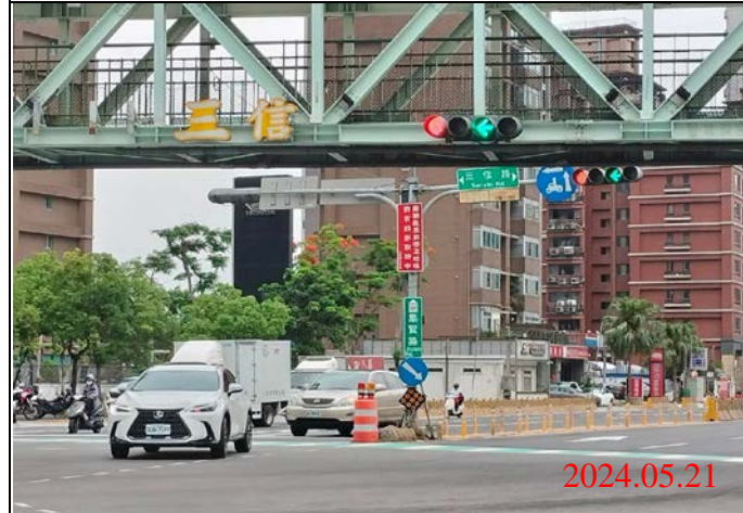
巡查日期地點：113.05.21/ Y23車站 照片說明：牌面設置狀況
