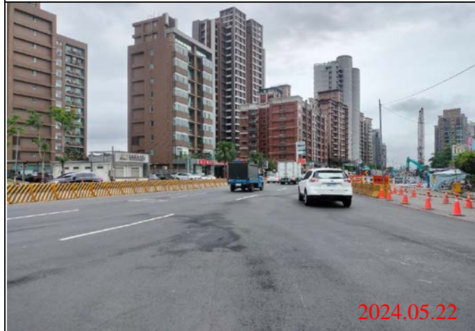
巡查日期地點：113.05.22/ Y23車站 照片說明：路面狀況
