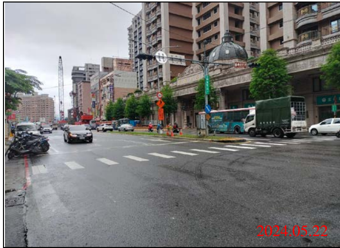
巡查日期地點：113.05.22/ Y22車站 照片說明：路面狀況
