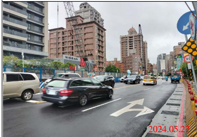
巡查日期地點：113.05.22/ Y22車站 照片說明：路面狀況
