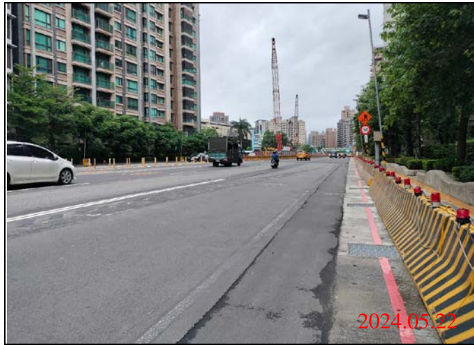
巡查日期地點：113.05.22/-23車站 照片說明：路面狀況
