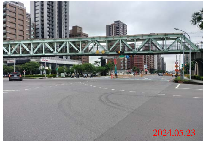
巡查日期地點：113.05.23/ Y23車站 照片說明：路面狀況
