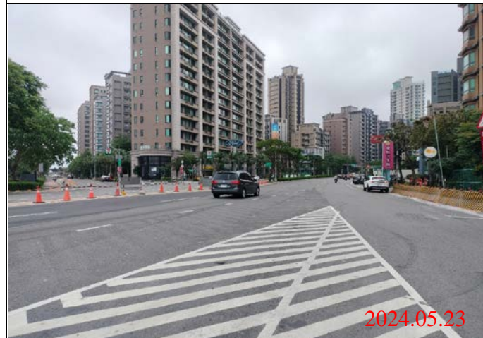
巡查日期地點：113.05.23/ Y22車站 照片說明：路面狀況
