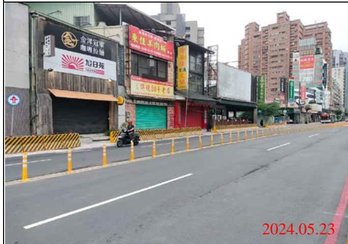
巡查日期地點：113.05.23/ Y21車站 照片說明：路面狀況
