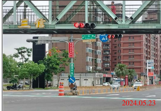
巡查日期地點：113.05.23/ Y23車站 照片說明：牌面設置狀況
