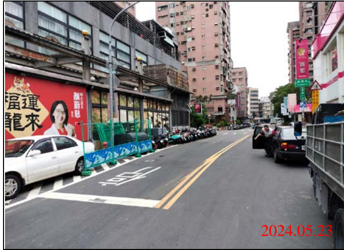
巡查日期地點：113.05.23/ Y21車站 照片說明：路面狀況
