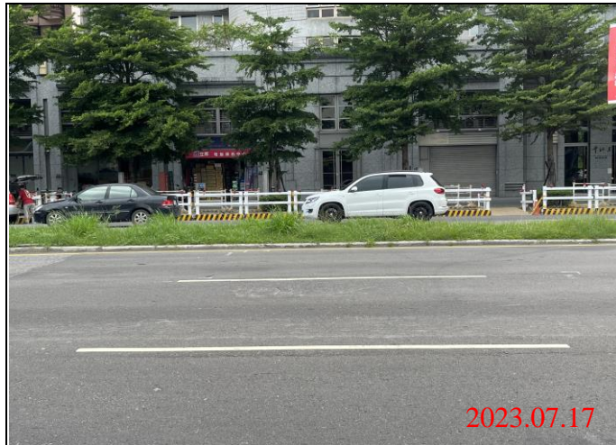
巡查日期地點：112.07.17/ Y23車站 照片說明：路面龜裂狀況
