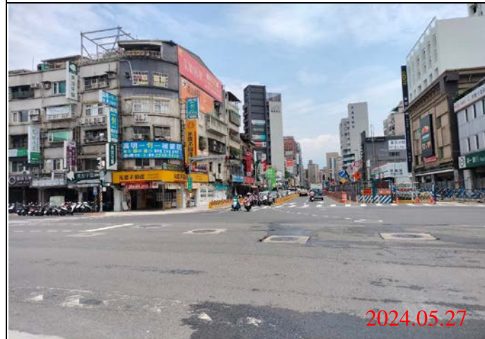
巡查日期地點：113.05.27/ Y21車站 照片說明：路面狀況
