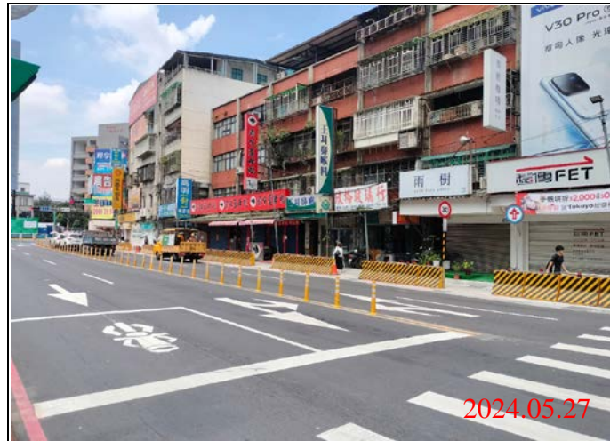
巡查日期地點：113.05.27/ Y21車站 照片說明：路面狀況
