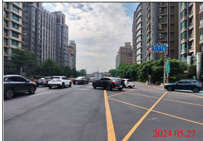
巡查日期地點：113.05.27/ Y23車站 照片說明：路面狀況
