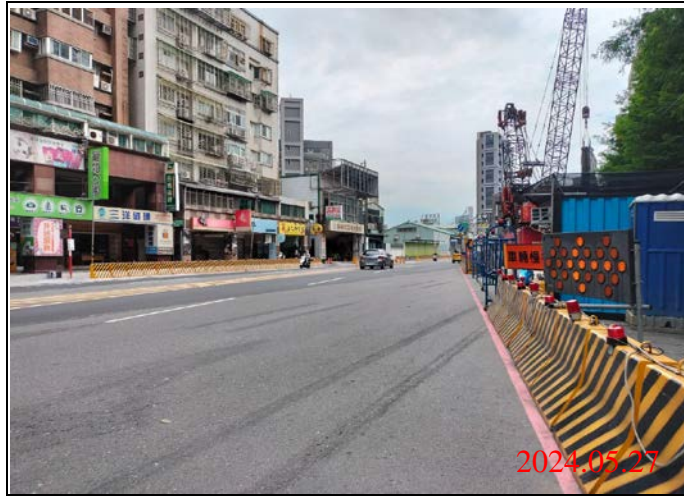
巡查日期地點：113.05.27/ Y22車站 照片說明：路面狀況
