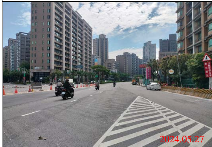
巡查日期地點：113.05.27/ Y22車站 照片說明：路面狀況
