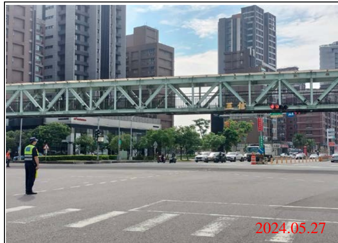
巡查日期地點：113.05.27/-23車站 照片說明：路面狀況
