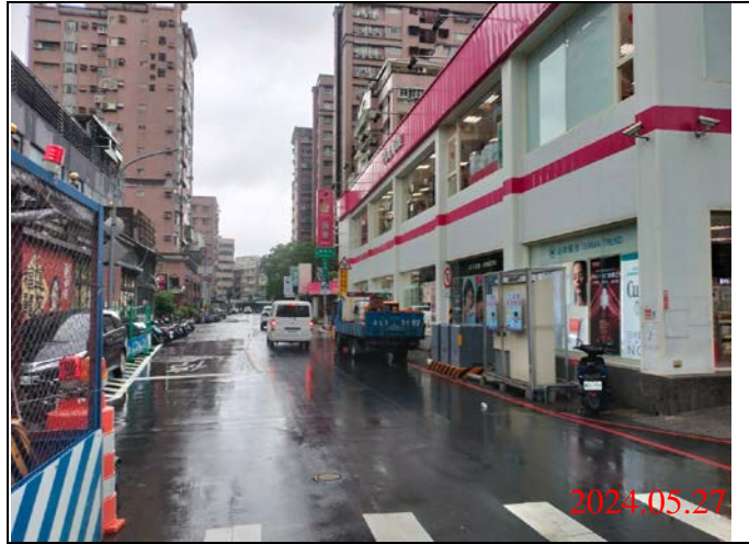
巡查日期地點：113.05.28/ Y21車站 照片說明：路面狀況
