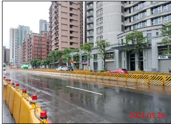
巡查日期地點：113.05.28/-23車站 照片說明：路面狀況
