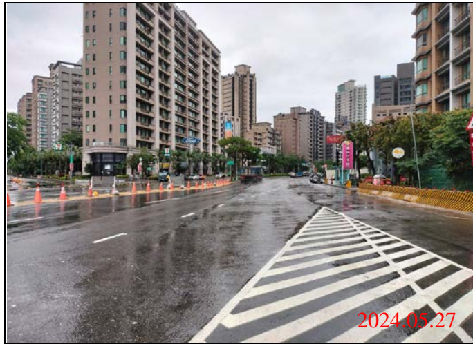
巡查日期地點：113.05.28/ Y22車站 照片說明：路面狀況
