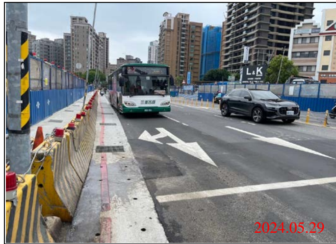
巡查日期地點：113.05.29/ Y22車站 照片說明：道路修補完畢
