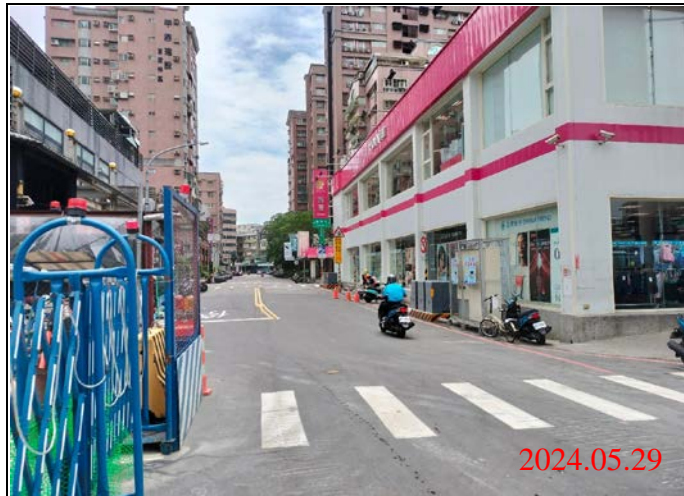
巡查日期地點：113.05.29/ Y21車站 照片說明：路面狀況
