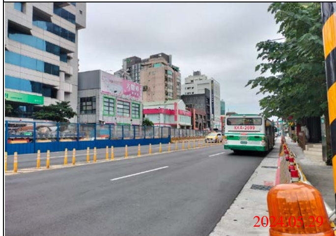
巡查日期地點：113.05.29/ Y21車站 照片說明：路面狀況
