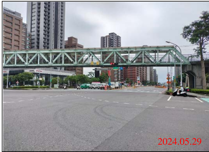
巡查日期地點：113.05.29/-23車站 照片說明：路面狀況
