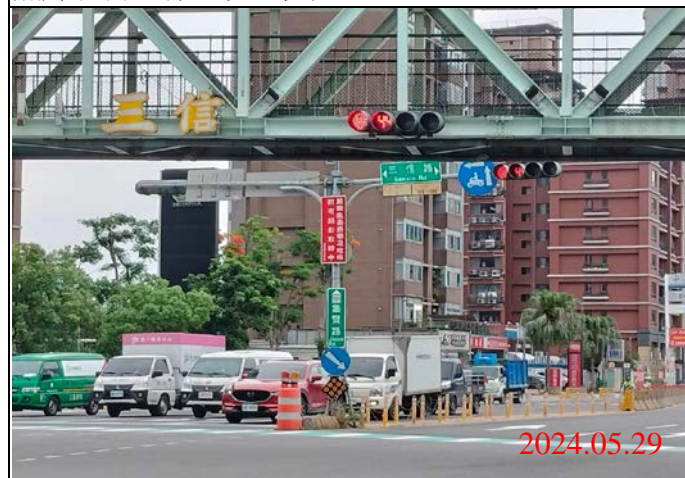
巡查日期地點：113.05.29/ Y23車站 照片說明：牌面設置狀況
