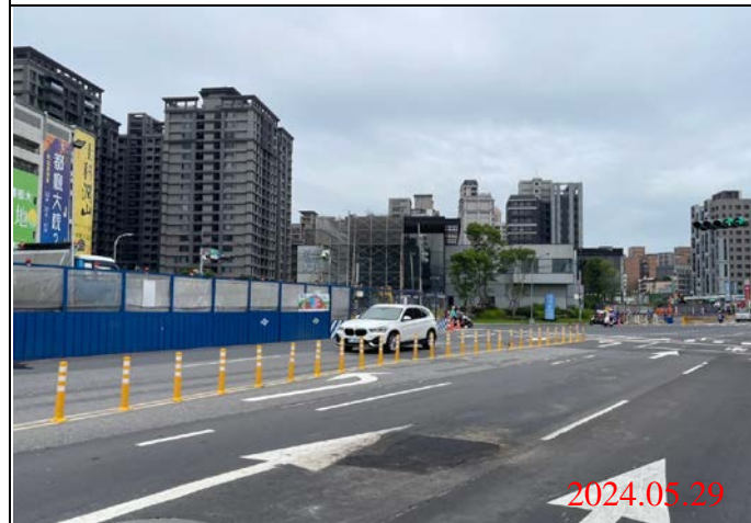
巡查日期地點：113.05.29/ Y22車站 照片說明：道路修補完畢
