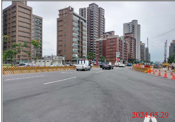
巡查日期地點：113.05.29/ Y23車站 照片說明：路面狀況
