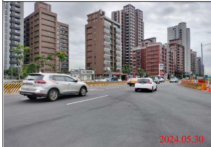
巡查日期地點：113.05.30/ Y23車站 照片說明：路面狀況
