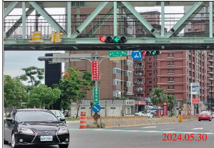
巡查日期地點：113.05.30/ Y23車站 照片說明：牌面設置狀況
