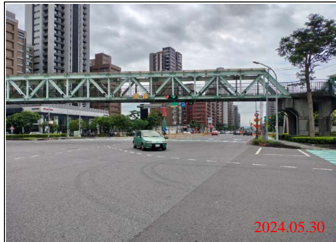
巡查日期地點：113.05.30/-23車站 照片說明：路面狀況
