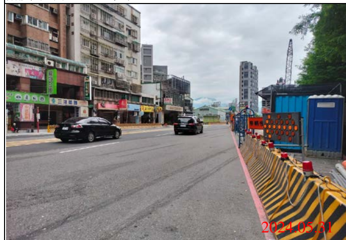
巡查日期地點：113.05.31/ Y22車站 照片說明：路面狀況
