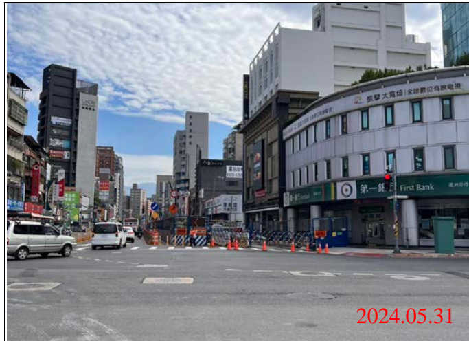
巡查日期地點：113.05.31/ Y21車站 照片說明：路面狀況
