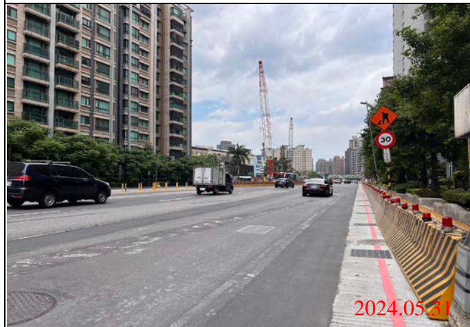
巡查日期地點：113.05.31/ Y23車站 照片說明：路面狀況
