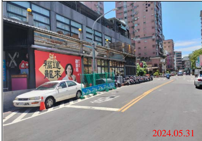
巡查日期地點：113.05.31/ Y21車站 照片說明：路面狀況
