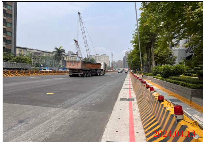
巡查日期地點：113.04.13/ Y23車站 照片說明：路面狀況
