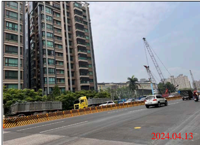
巡查日期地點：113.04.13/ Y23車站 照片說明：路面狀況
