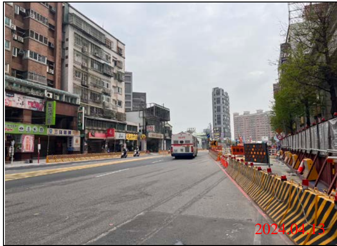
巡查日期地點：113.04.13/ Y22車站 照片說明：路面狀況
