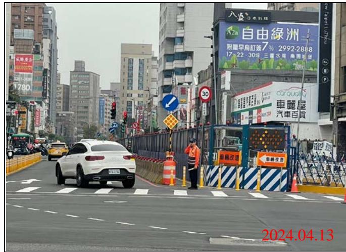
巡查日期地點：113.04.13/ Y21車站 照片說明：牌面設置狀況
