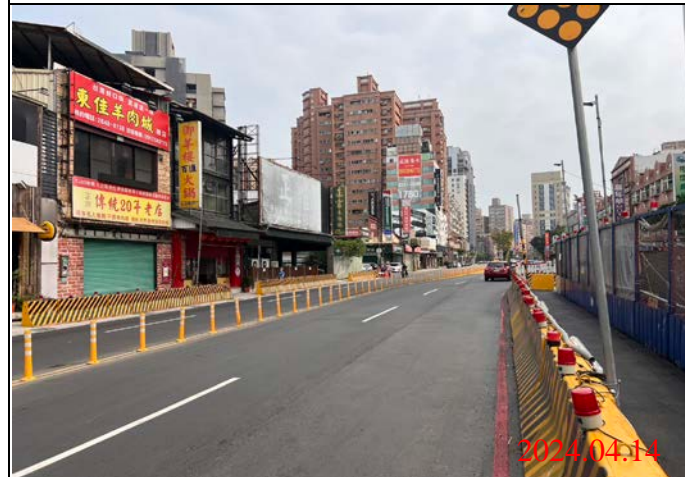
巡查日期地點：113.04.14/ Y21車站 照片說明：路面狀況
