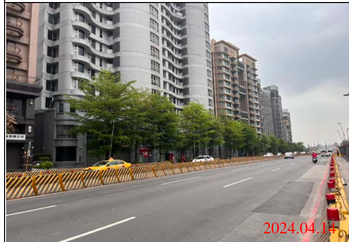
巡查日期地點：113.04.14/ Y23車站 照片說明：路面狀況
