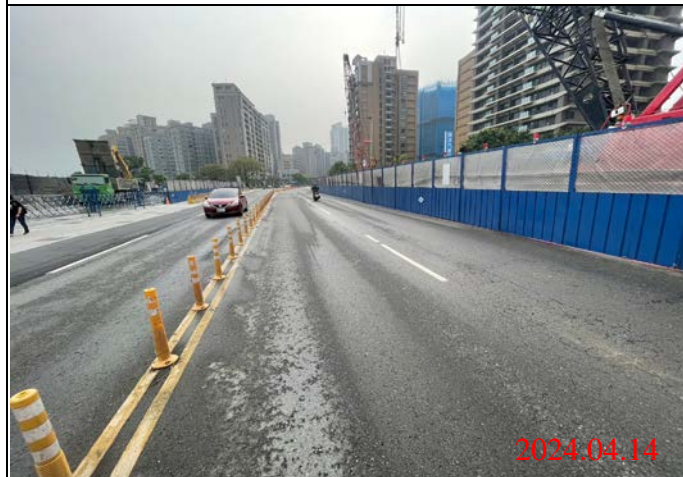
巡查日期地點：113.04.14/ Y22車站 照片說明：路面狀況
