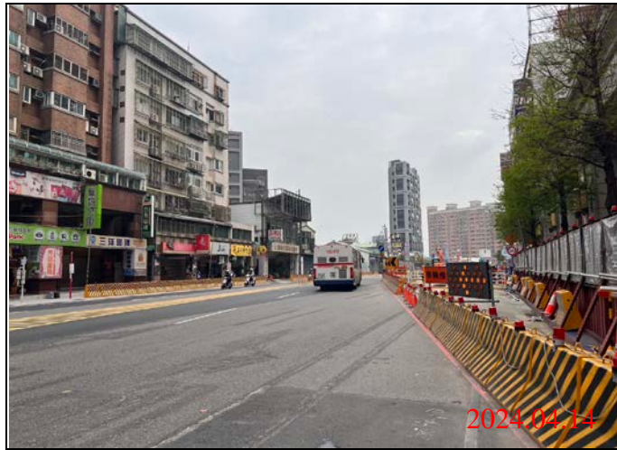
巡查日期地點：113.04.14/ Y22車站 照片說明：路面狀況
