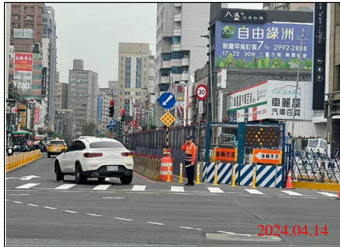
巡查日期地點：113.04.14/ Y21車站 照片說明：牌面設置狀況
