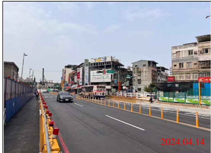
巡查日期地點：113.04.14/ Y21車站 照片說明：路面狀況
