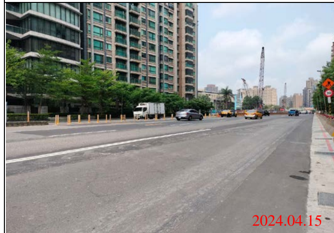
巡查日期地點：113.04.15/ Y23車站 照片說明：路面狀況
