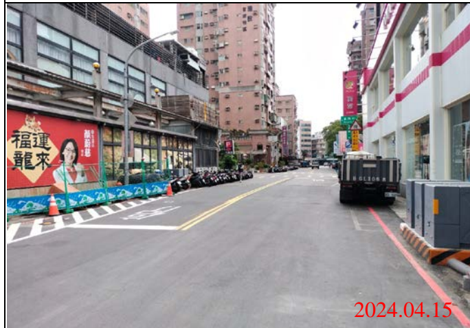
巡查日期地點：113.04.15/ Y21車站 照片說明：路面狀況
