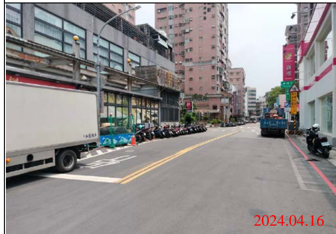
巡查日期地點：113.04.16/ Y21車站 照片說明：路面狀況
