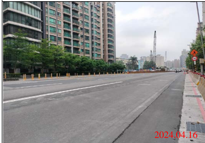
巡查日期地點：113.04.16/ Y23車站 照片說明：路面狀況
