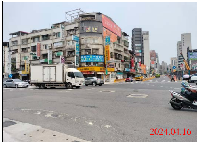
巡查日期地點：113.04.16/ Y21車站 照片說明：路面狀況
