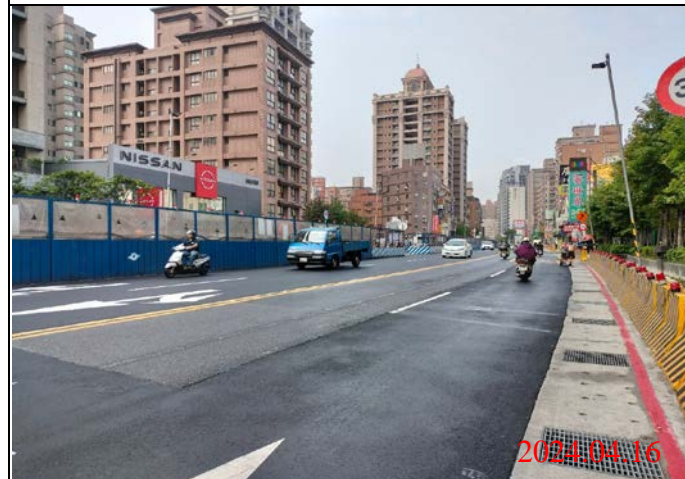
巡查日期地點：113.04.16/ Y22車站 照片說明：路面狀況
