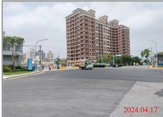
巡查日期地點：113.04.17/ Y22車站 照片說明：路面狀況
