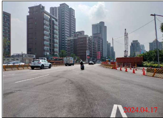
巡查日期地點：113.04.17/ Y23車站 照片說明：路面狀況
