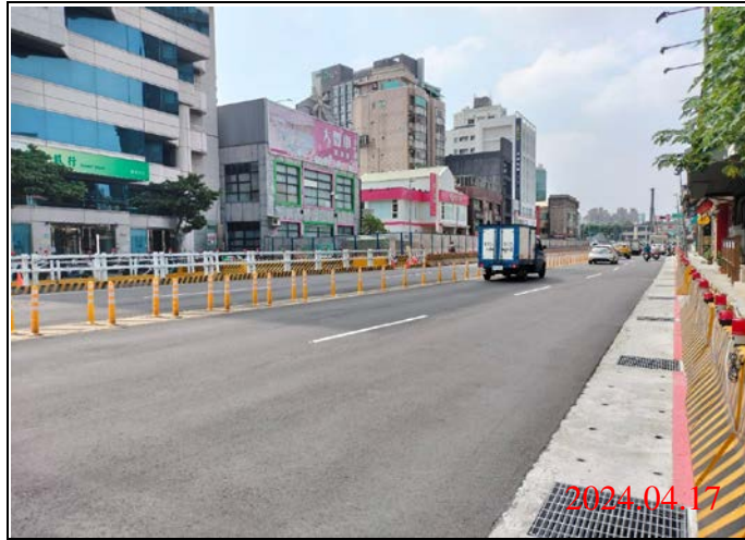
巡查日期地點：113.04.17/ Y21車站 照片說明：路面狀況
