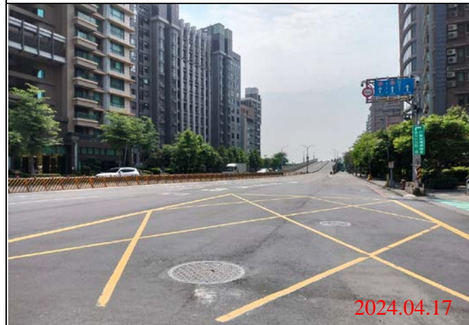
巡查日期地點：113.04.17/ Y23車站 照片說明：路面狀況
