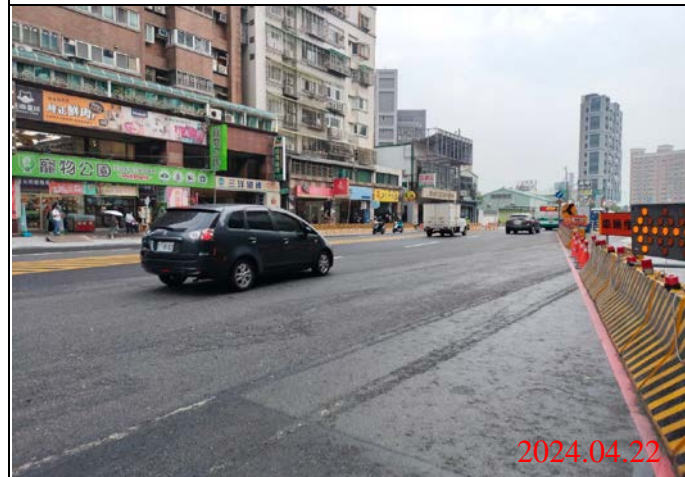
巡查日期地點：113.04.22/ Y22車站 照片說明：路面狀況
