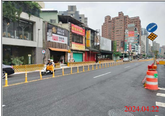
巡查日期地點：113.04.22/ Y21車站 照片說明：路面狀況
