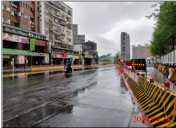
巡查日期地點：113.04.24/ Y22車站 照片說明：路面狀況
