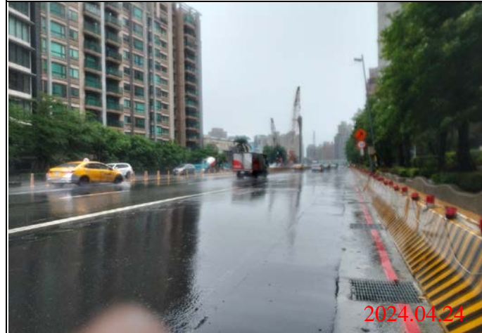
巡查日期地點：113.04.24/ Y23車站 照片說明：路面狀況
