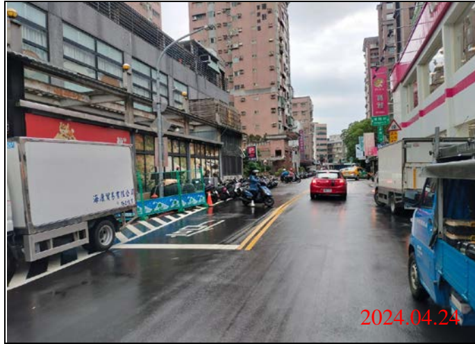
巡查日期地點：113.04.24/ Y21車站 照片說明：路面狀況
