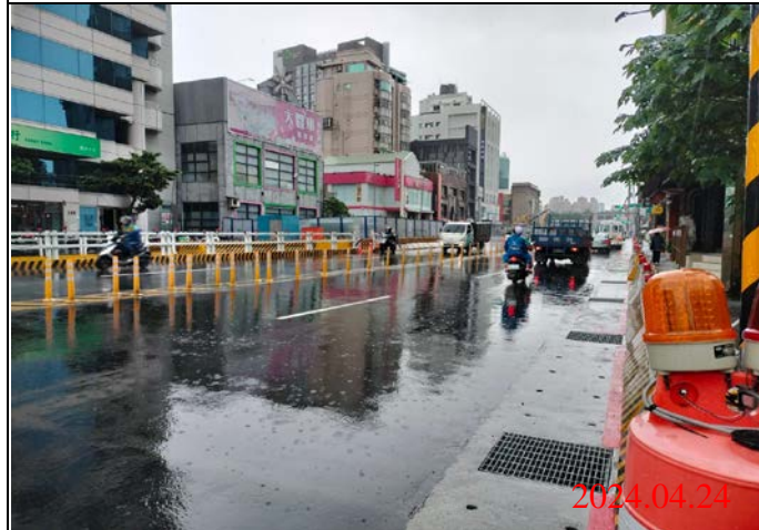
巡查日期地點：113.04.24/ Y21車站 照片說明：路面狀況
