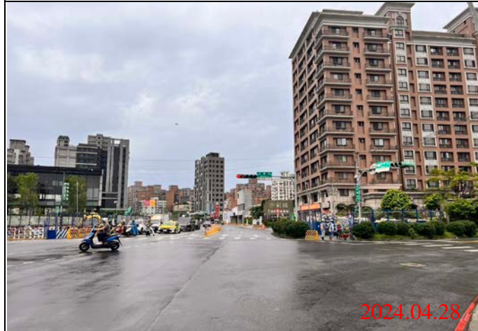
巡查日期地點：113.04.28/ Y22車站 照片說明：路面狀況
