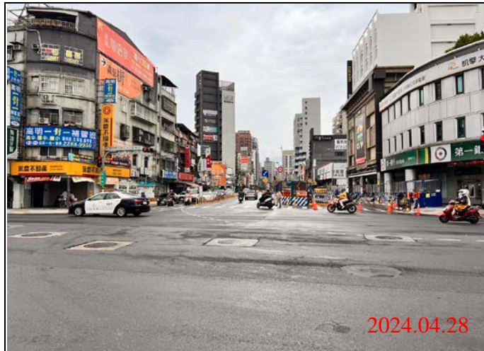
巡查日期地點：113.04.28/ Y21車站 照片說明：路面狀況
