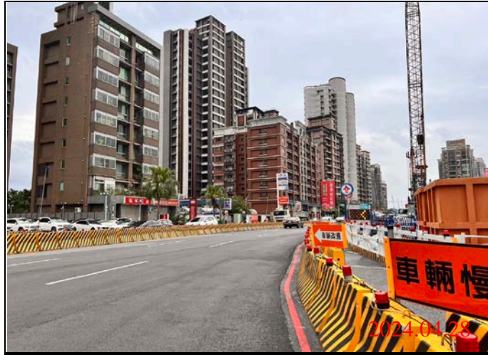
巡查日期地點：113.04.28/ Y23車站 照片說明：路面狀況
