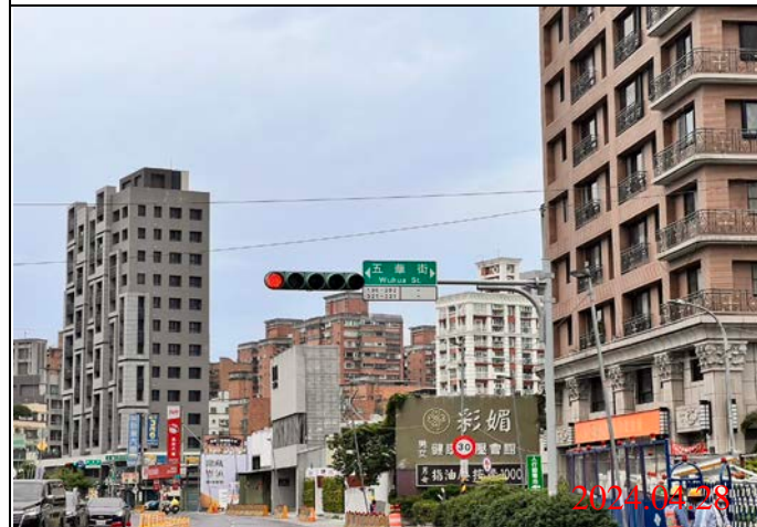
巡查日期地點：113.04.28/ Y22車站 照片說明：牌面設置狀況
