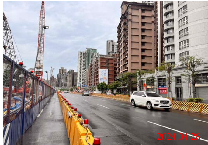
巡查日期地點：113.04.28/ Y23車站 照片說明：路面狀況
