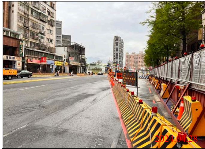
巡查日期地點：113.04.28/ Y22車站 照片說明：路面狀況
