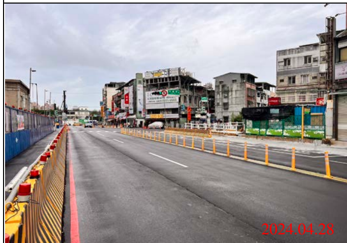
巡查日期地點：113.04.28/ Y21車站 照片說明：路面狀況
