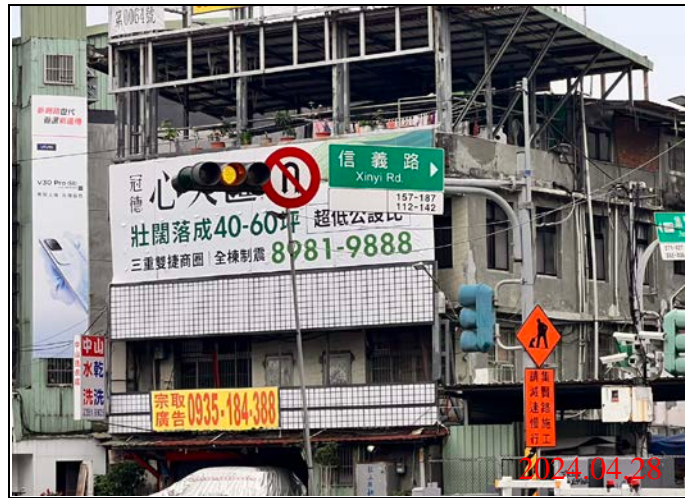
巡查日期地點：113.04.28/ Y21車站 照片說明：牌面設置狀況
