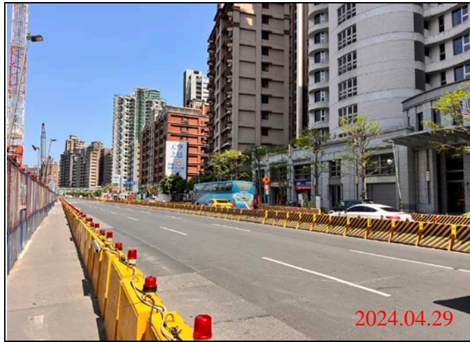
巡查日期地點：113.04.29/ Y23車站 照片說明：路面狀況
