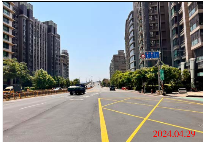
巡查日期地點：113.04.29/ Y23車站 照片說明：路面狀況
