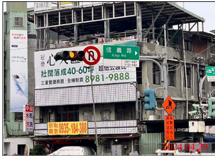
巡查日期地點：113.04.29/ Y21車站 照片說明：牌面設置狀況
