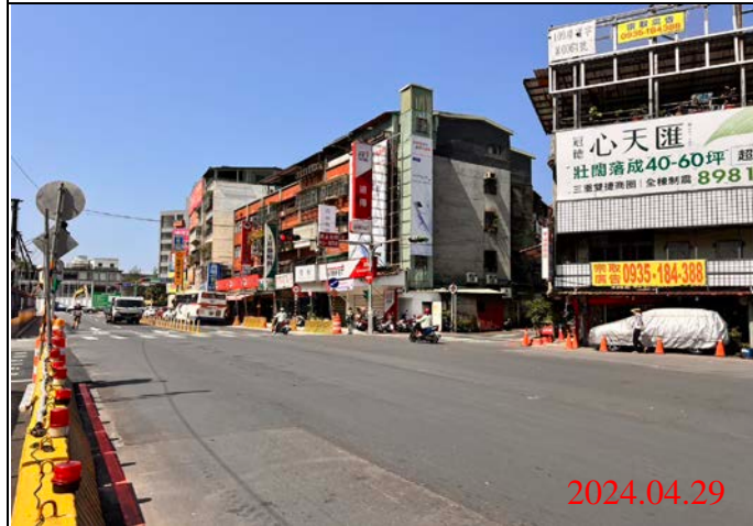
巡查日期地點：113.04.29/ Y21車站 照片說明：路面狀況
