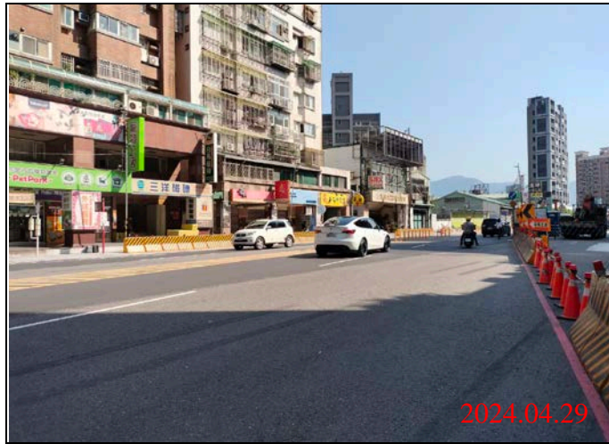
巡查日期地點：113.04.29/ Y22車站 照片說明：路面狀況
