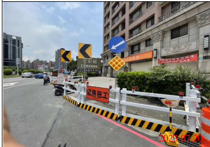
巡查日期地點：112.07.20/ Y22車站 照片說明：牌面設置狀況
