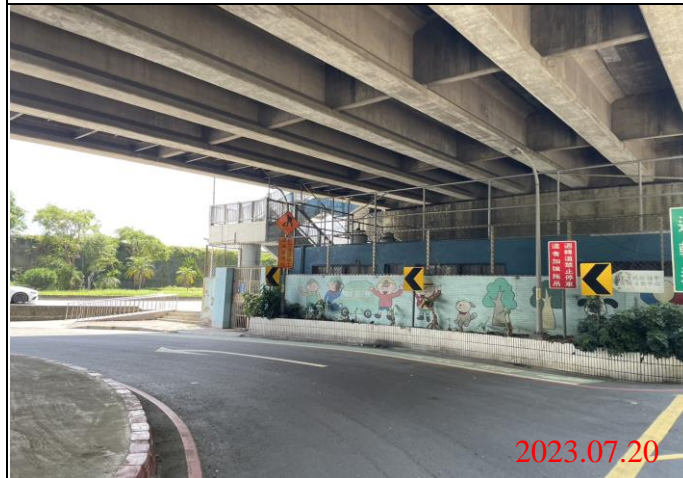
巡查日期地點：112.07.20/ Y23車站 照片說明：牌面設置狀況
