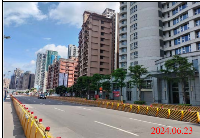
巡查日期地點：113.06.23/ Y23車站 照片說明：路面狀況
