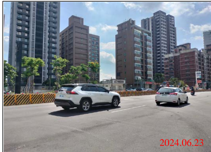
巡查日期地點：113.06.23/-23車站 照片說明：路面狀況
