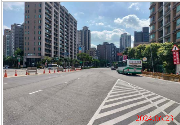
巡查日期地點：113.06.23/ Y22車站 照片說明：路面狀況
