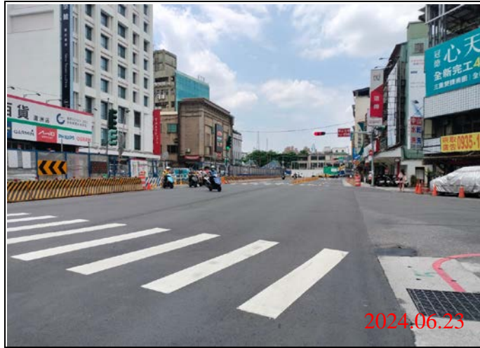
巡查日期地點：113.06.23/ Y21車站 照片說明：路面狀況
