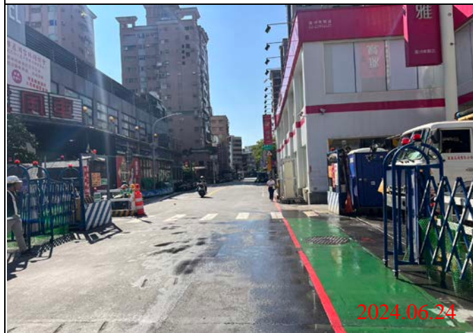
巡查日期地點：113.06.24/ Y21車站 照片說明：路面狀況
