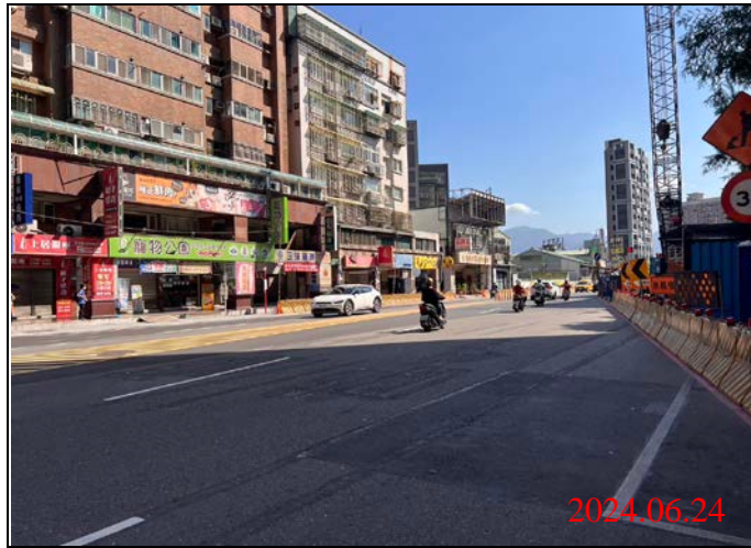
巡查日期地點：113.06.24/ Y22車站 照片說明：路面狀況
