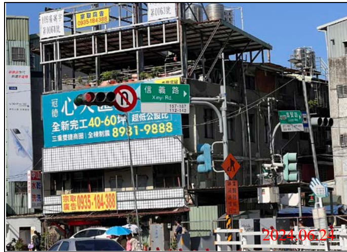
巡查日期地點：113.06.24/ Y21車站 照片說明：牌面設置狀況
