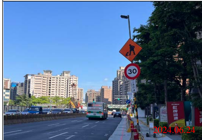
巡查日期地點：113.06.24/ Y23車站 照片說明：牌面設置狀況
