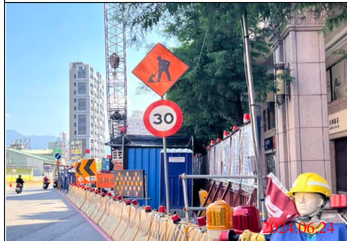
巡查日期地點：113.06.24/ Y22車站 照片說明：牌面設置狀況
