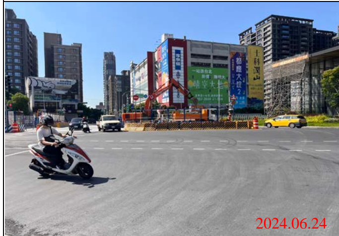
巡查日期地點：113.06.24/ Y22車站 照片說明：路面狀況
