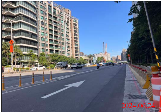
巡查日期地點：113.06.24/ Y23車站 照片說明：路面狀況
