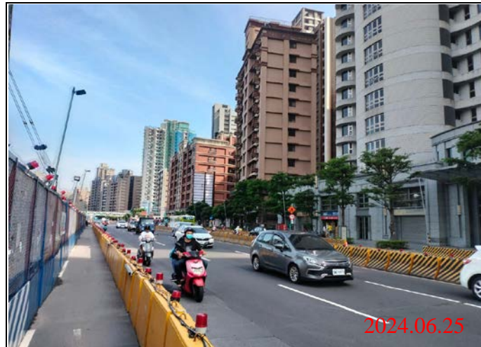
巡查日期地點：113.06.25/-23車站 照片說明：路面狀況
