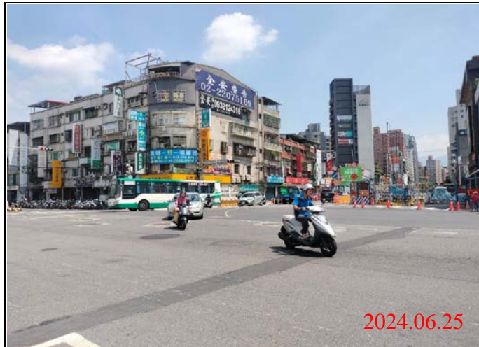
巡查日期地點：113.06.25/ Y21車站 照片說明：路面狀況
