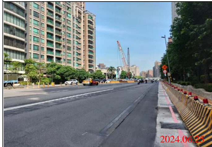
巡查日期地點：113.06.25/ Y23車站 照片說明：路面狀況
