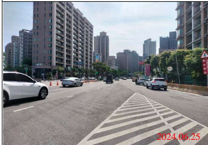
巡查日期地點：113.06.25/ Y22車站 照片說明：路面狀況
