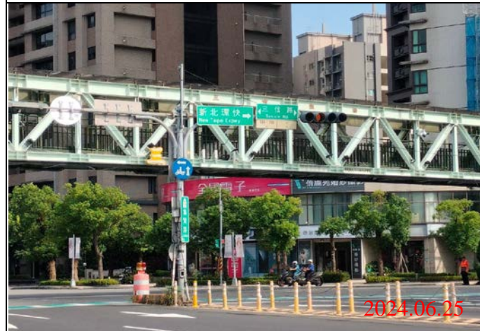
巡查日期地點：113.06.25/ Y23車站 照片說明：牌面設置狀況
