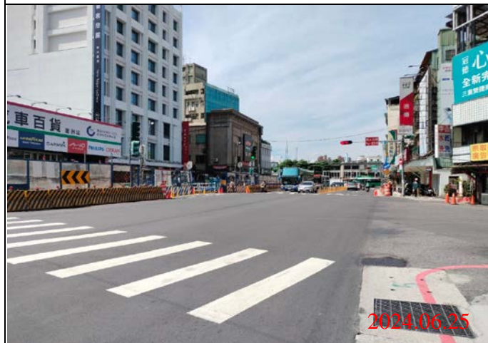
巡查日期地點：113.06.25/ Y21車站 照片說明：路面狀況
