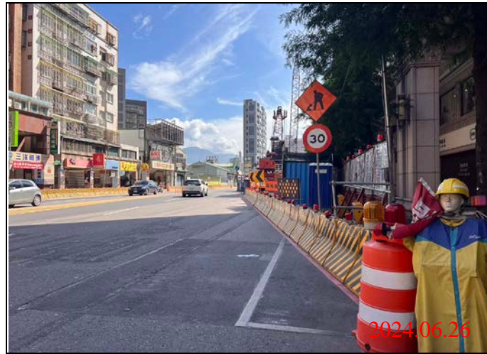
巡查日期地點：113.06.26/ Y22車站 照片說明：路面狀況
