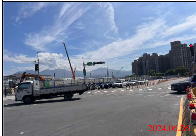
巡查日期地點：113.06.26/ Y22車站 照片說明：路面狀況
