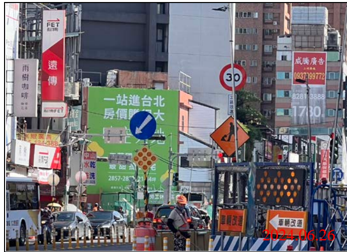
巡查日期地點：113.06.26/ Y21車站 照片說明：牌面設置狀況
