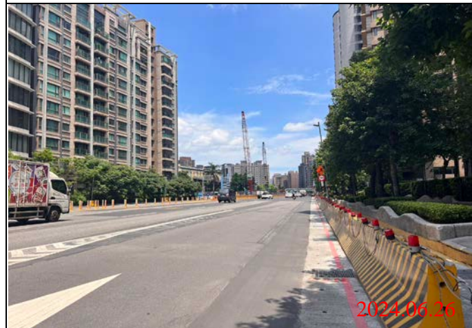
巡查日期地點：113.06.26/ Y23車站 照片說明：路面狀況
