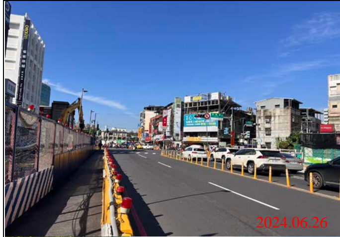
巡查日期地點：113.06.26/ Y21車站 照片說明：路面狀況
