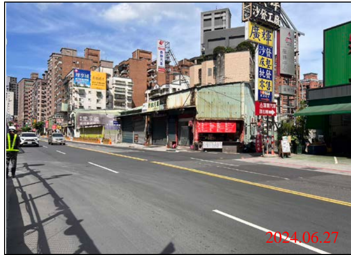
巡查日期地點：113.06.27/ Y22車站 照片說明：路面狀況
