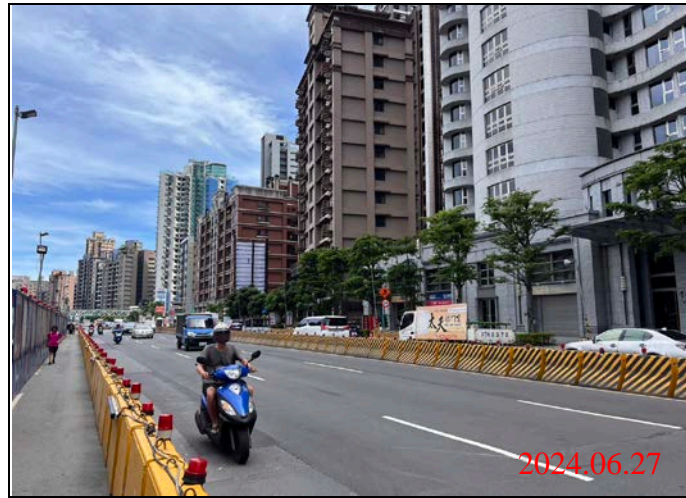
巡查日期地點：113.06.27/-23車站 照片說明：路面狀況
