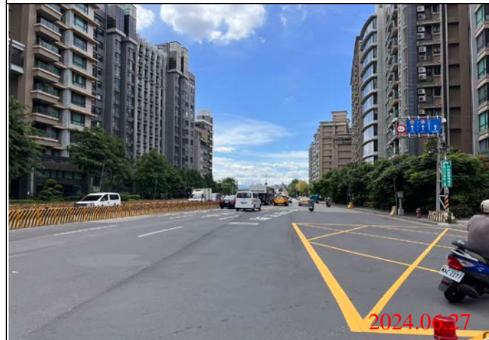
巡查日期地點：113.06.27/ Y23車站 照片說明：路面狀況
