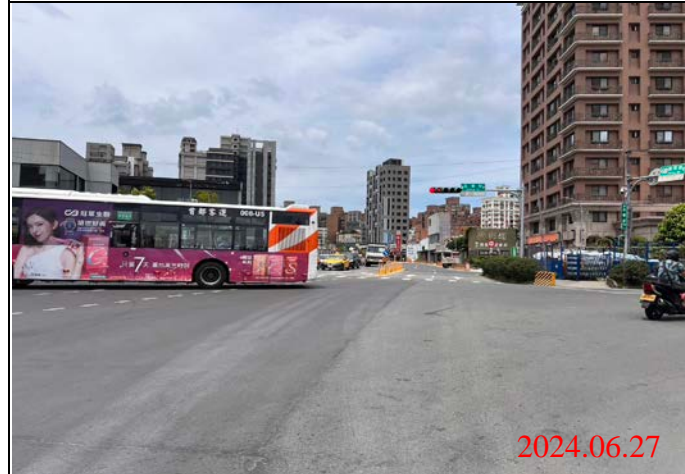
巡查日期地點：113.06.27/ Y22車站 照片說明：路面狀況
