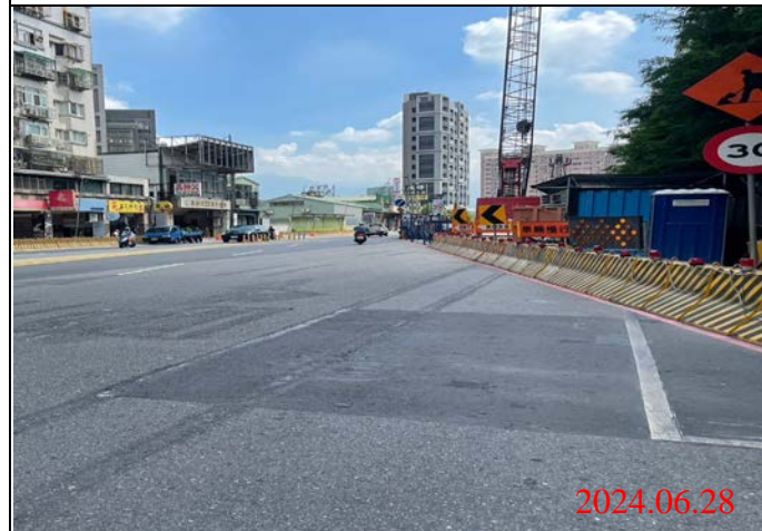
巡查日期地點：113.06.28/ Y22車站 照片說明：牌面設置狀況
