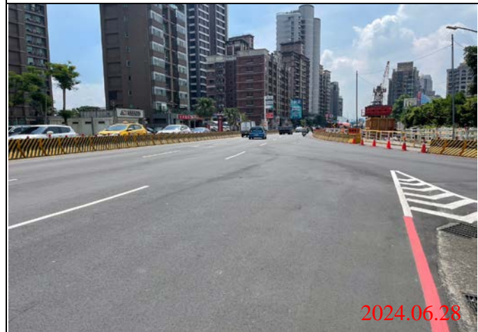
巡查日期地點：113.06.28/ Y23車站 照片說明：路面狀況
