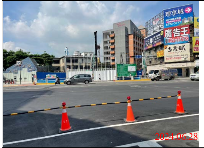
巡查日期地點：113.06.28/ Y21車站 照片說明：路面狀況
