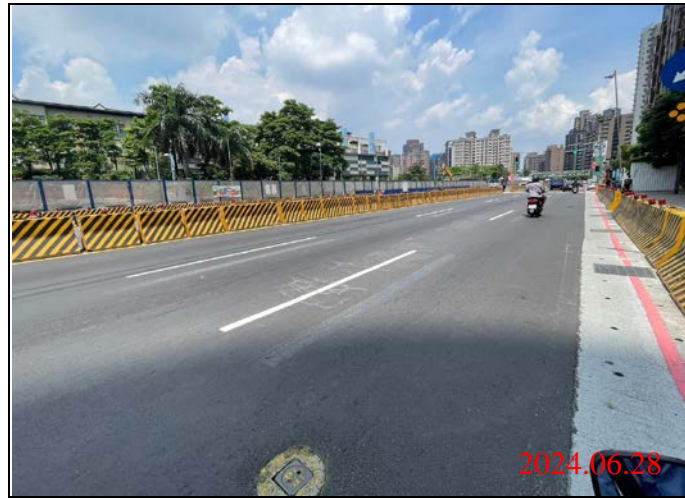
巡查日期地點：113.06.28/ Y23車站 照片說明：路面狀況
