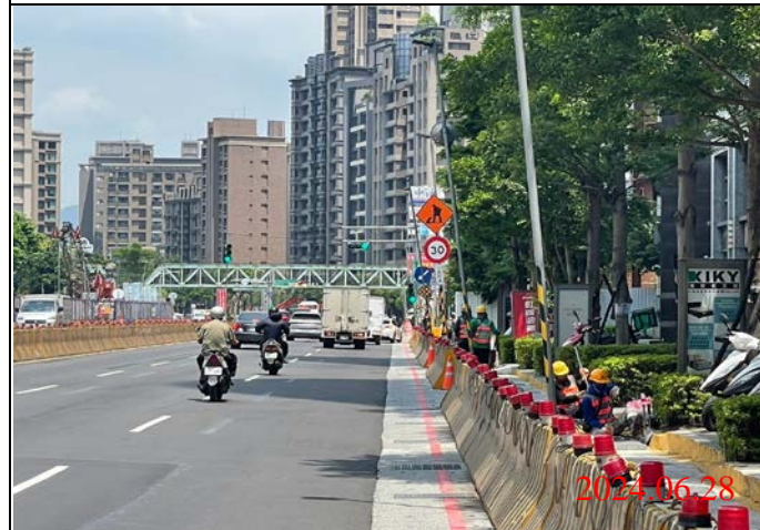
巡查日期地點：113.06.28/ Y23車站 照片說明：牌面設置狀況
