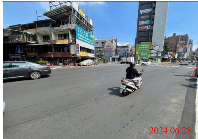
巡查日期地點：113.06.28/ Y21車站 照片說明：路面狀況
