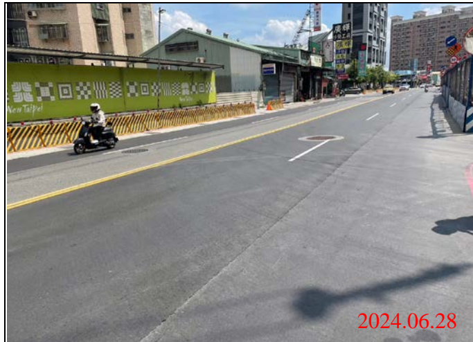
巡查日期地點：113.06.28/ Y22車站 照片說明：路面狀況
