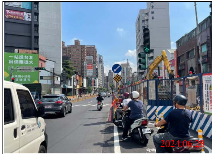
巡查日期地點：113.06.28/ Y21車站 照片說明：牌面設置狀況
