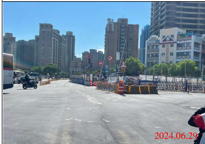
巡查日期地點：113.06.29/ Y22車站 照片說明：路面狀況
