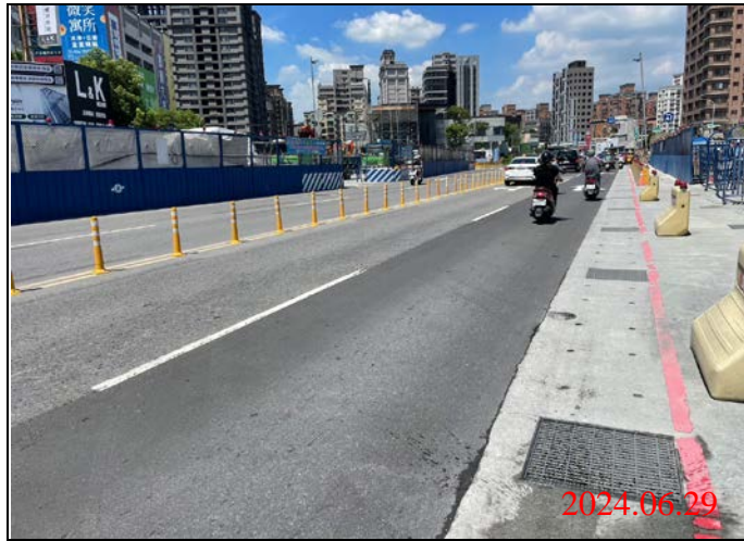
巡查日期地點：113.06.29/ Y22車站 照片說明：路面狀況
