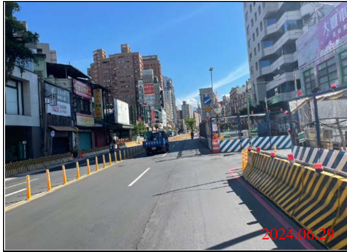
巡查日期地點：113.06.29/ Y21車站 照片說明：牌面設置狀況
