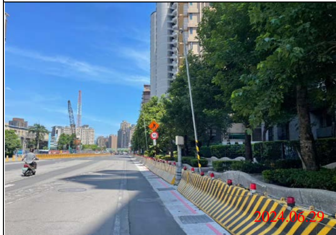
巡查日期地點：113.06.29/ Y23車站 照片說明：牌面設置狀況
