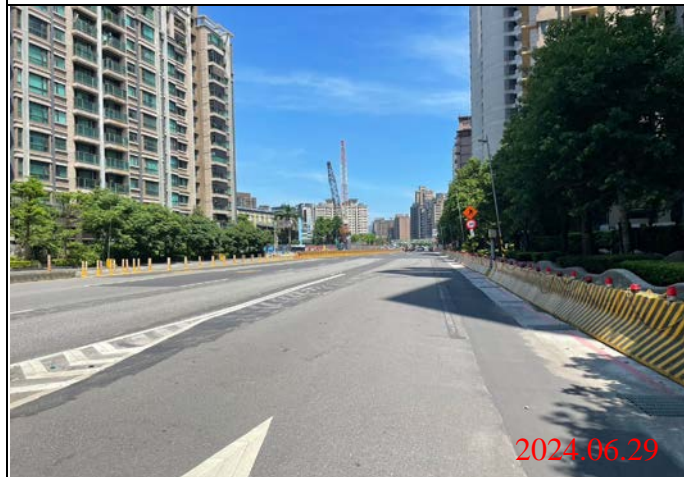
巡查日期地點：113.06.29/ Y23車站 照片說明：路面狀況
