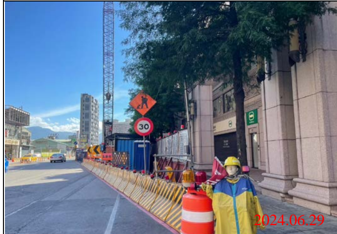
巡查日期地點：113.06.29/ Y22車站 照片說明：牌面設置狀況
