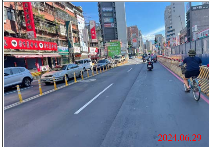
巡查日期地點：113.06.29/ Y21車站 照片說明：路面狀況
