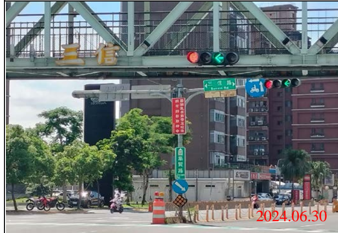
巡查日期地點：113.06.30/ Y23車站 照片說明：牌面設置狀況
