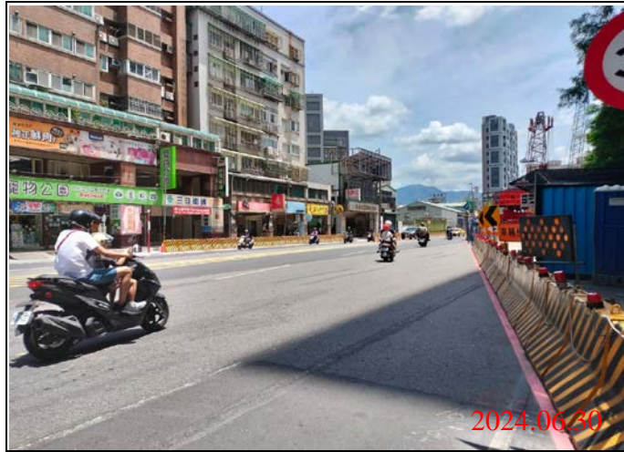
巡查日期地點：113.06.30/ Y22車站 照片說明：路面狀況
