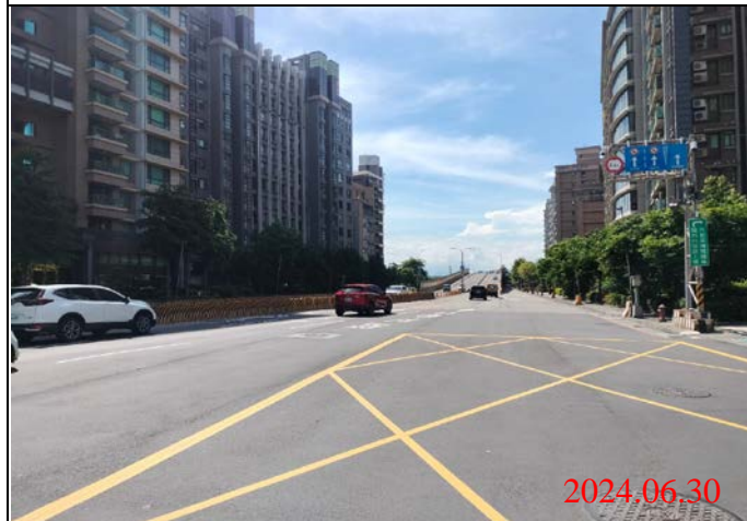
巡查日期地點：113.06.30/ Y23車站 照片說明：路面狀況
