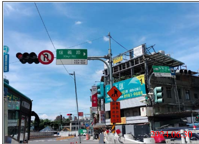
巡查日期地點：113.06.30/ Y21車站 照片說明：牌面設置狀況
