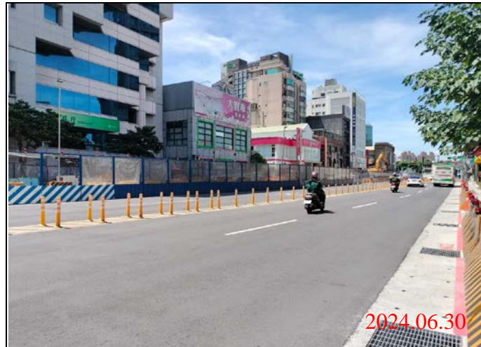
巡查日期地點：113.06.30/ Y21車站 照片說明：路面狀況
