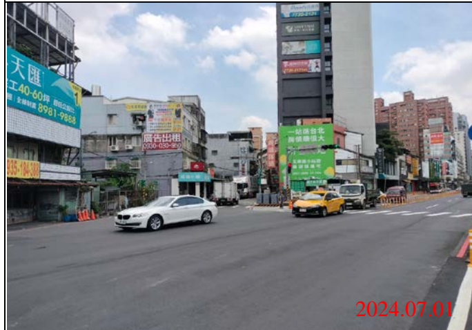
巡查日期地點：113.07.01/ Y21車站 照片說明：路面狀況
