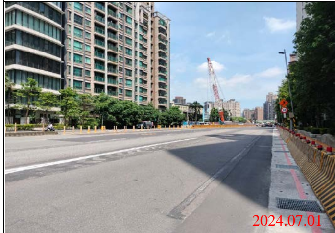
巡查日期地點：113.07.01/ Y23車站 照片說明：路面狀況
