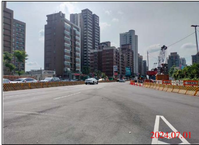
巡查日期地點：113.07.01/-23車站 照片說明：路面狀況
