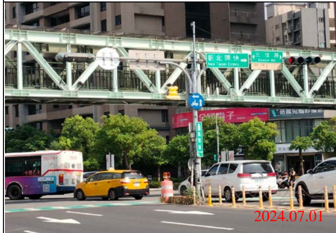
巡查日期地點：113.07.01/ Y23車站 照片說明：牌面設置狀況
