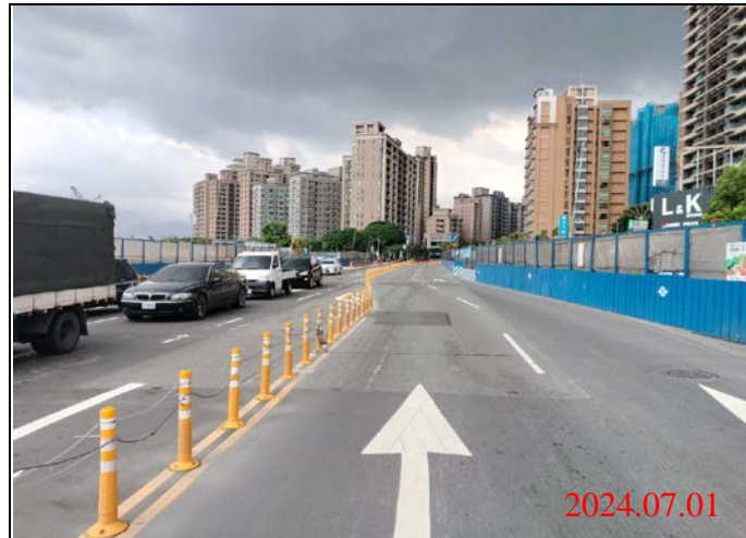
巡查日期地點：113.07.01/ Y22車站 照片說明：路面狀況
