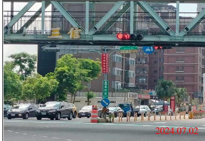
巡查日期地點：113.07.02/ Y23車站 照片說明：牌面設置狀況
