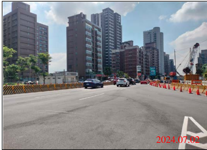
巡查日期地點：113.07.02/-23車站 照片說明：路面狀況
