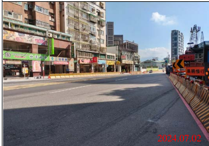
巡查日期地點：113.07.02/ Y22車站 照片說明：路面狀況
