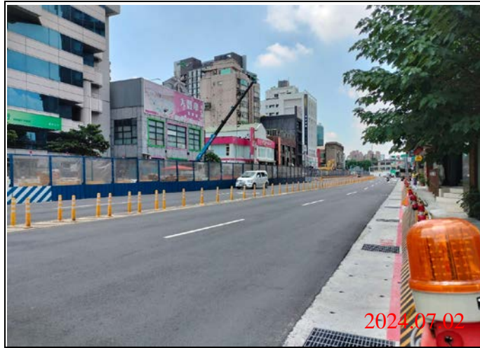
巡查日期地點：113.07.02/ Y21車站 照片說明：路面狀況
