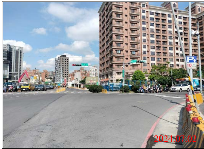
巡查日期地點：113.07.02/ Y22車站 照片說明：路面狀況
