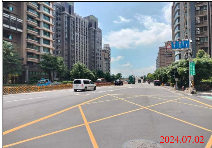
巡查日期地點：113.07.02/ Y23車站 照片說明：路面狀況
