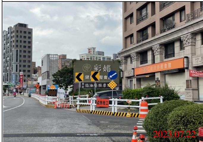
巡查日期地點：112.07.22/ Y22車站 照片說明：牌面設置狀況
