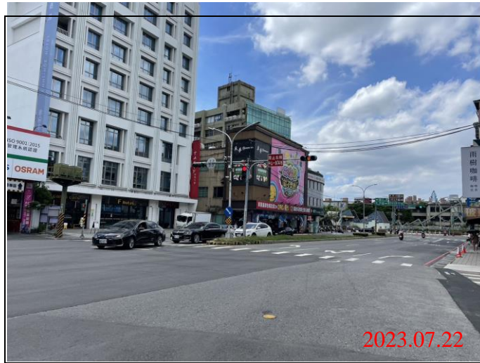
巡查日期地點：112.07.22/ Y21車站 照片說明：牌面設置狀況
