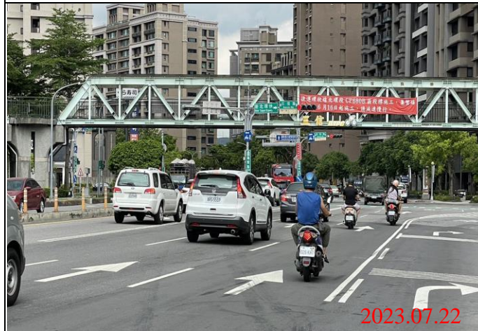
巡查日期地點：112.07.22/ Y23車站 照片說明：牌面設置狀況
