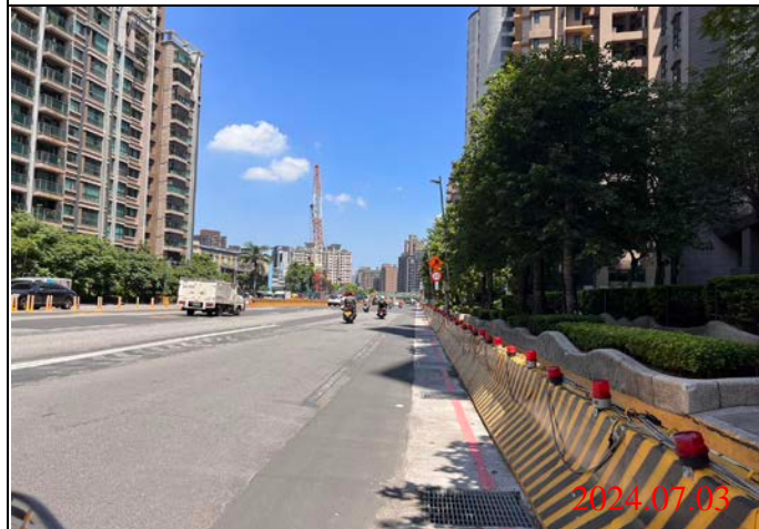
巡查日期地點：113.07.03/ Y23車站 照片說明：路面狀況
