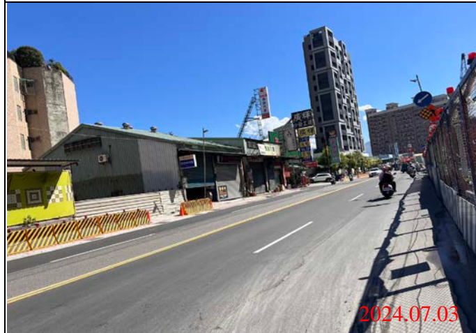
巡查日期地點：113.07.03/ Y22車站 照片說明：路面狀況
