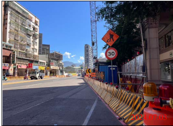
巡查日期地點：113.07.03/ Y22車站 照片說明：路面狀況
