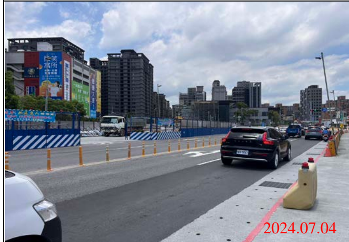
巡查日期地點：113.07.04/ Y22車站 照片說明：路面狀況
