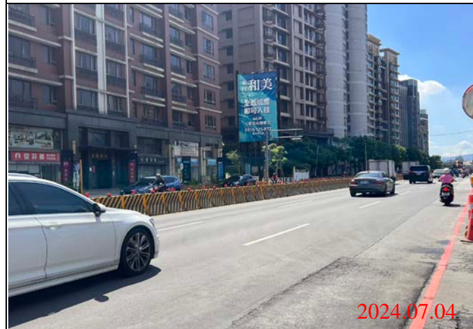
巡查日期地點：113.07.04/ Y23車站 照片說明：路面狀況
