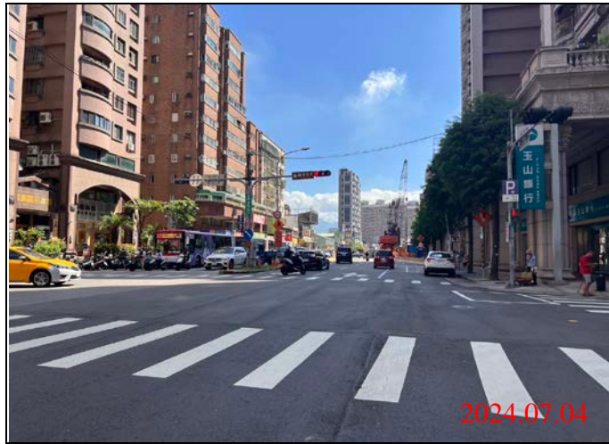
巡查日期地點：113.07.04/ Y22車站 照片說明：路面狀況
