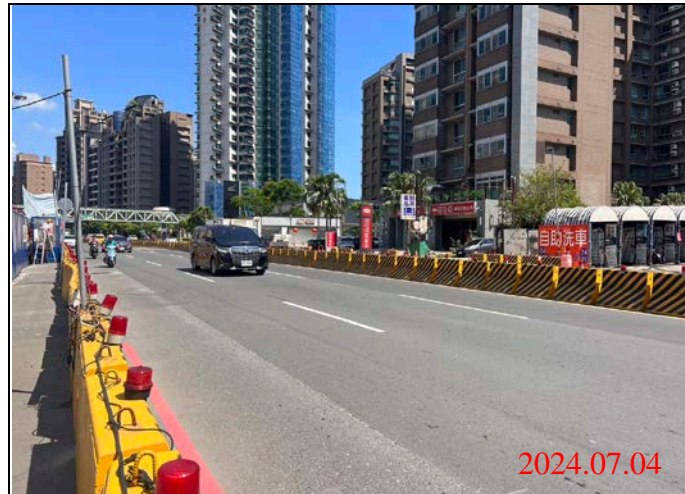
巡查日期地點：113.07.04/-23車站 照片說明：路面狀況
