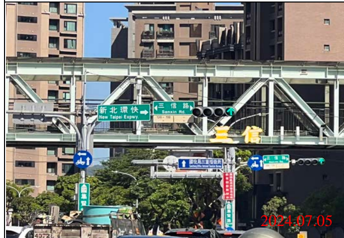
巡查日期地點：113.07.05/ Y23車站 照片說明：牌面設置狀況
