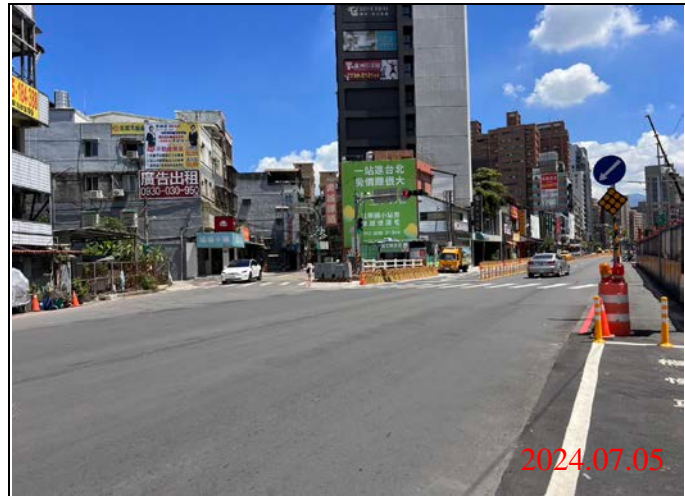
巡查日期地點：113.07.05/ Y21車站 照片說明：路面狀況
