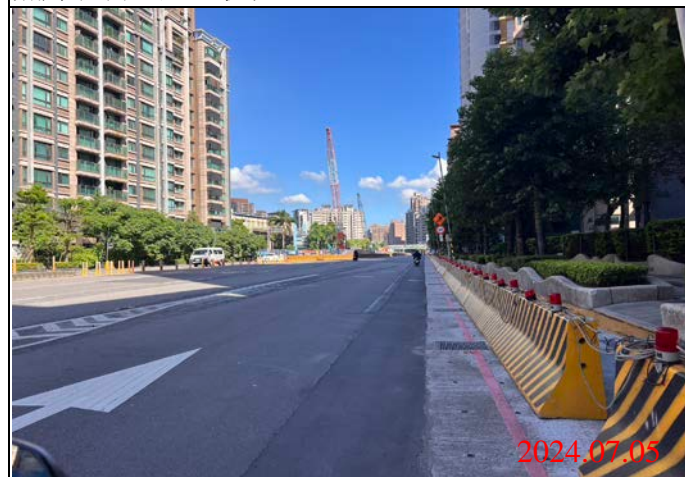
巡查日期地點：113.07.05/ Y23車站 照片說明：路面狀況
