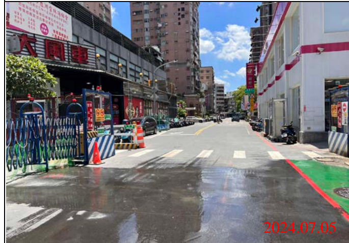
巡查日期地點：113.07.05/ Y21車站 照片說明：路面狀況
