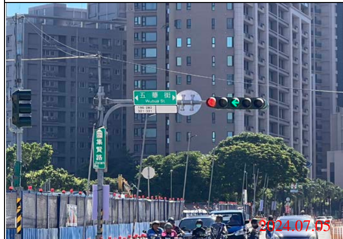
巡查日期地點：113.07.05/ Y22車站 照片說明：牌面設置狀況
