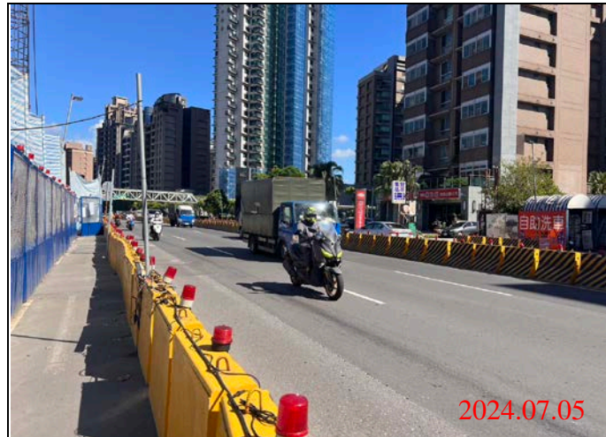
巡查日期地點：113.07.05/-23車站 照片說明：路面狀況
