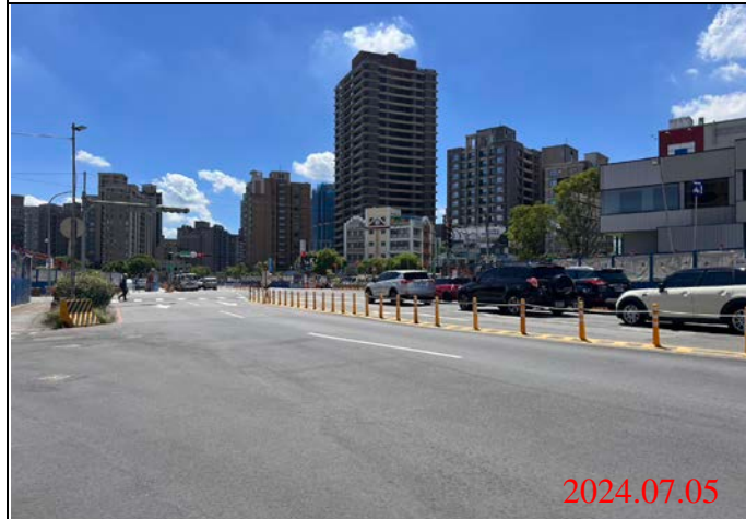
巡查日期地點：113.07.05/ Y22車站 照片說明：路面狀況
