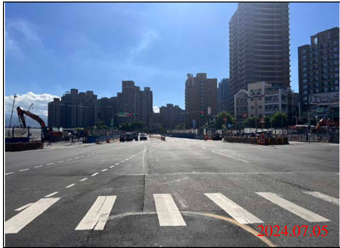
巡查日期地點：113.07.05/ Y22車站 照片說明：路面狀況
