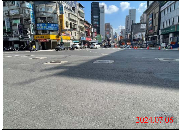
巡查日期地點：113.07.06/ Y21車站 照片說明：路面狀況
