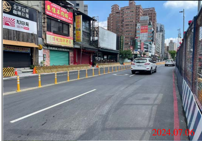
巡查日期地點：113.07.06/ Y21車站 照片說明：路面狀況
