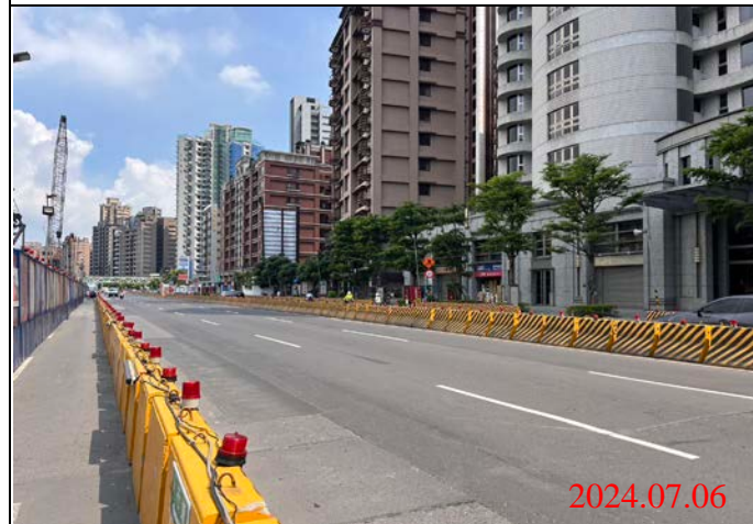
巡查日期地點：113.07.06/ Y23車站 照片說明：路面狀況
