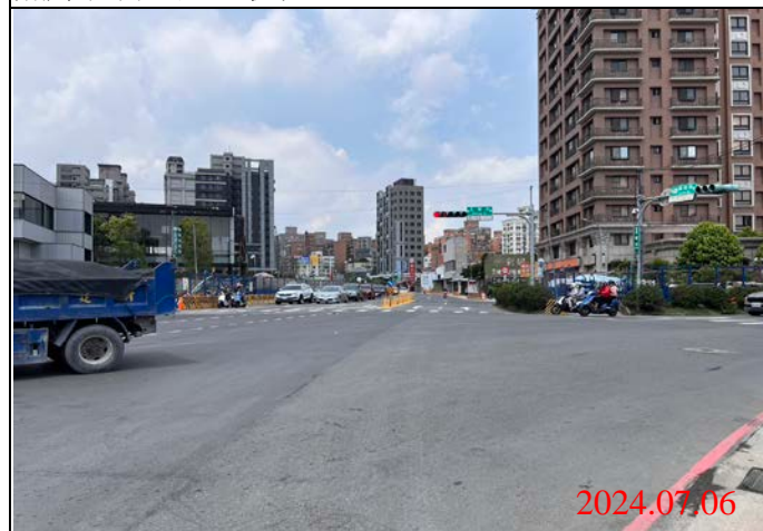
巡查日期地點：113.07.06/ Y22車站 照片說明：路面狀況
