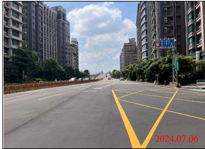
巡查日期地點：113.07.06/-23車站 照片說明：路面狀況
