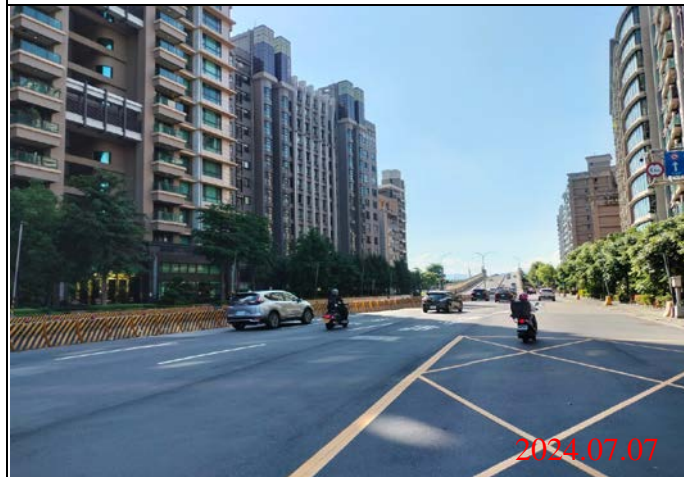
巡查日期地點：113.07.07/ Y23車站 照片說明：路面狀況
