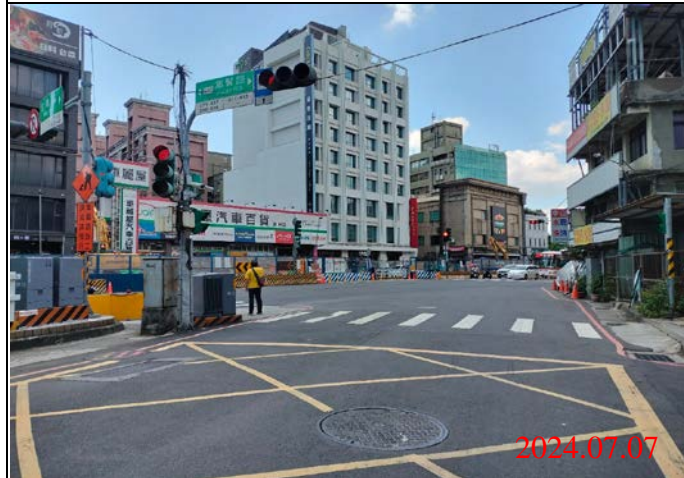
巡查日期地點：113.07.07/ Y21車站 照片說明：路面狀況
