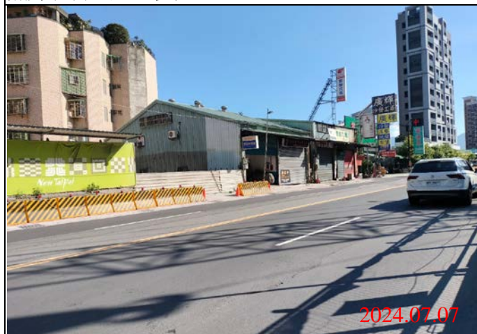
巡查日期地點：113.07.07/ Y22車站 照片說明：路面狀況
