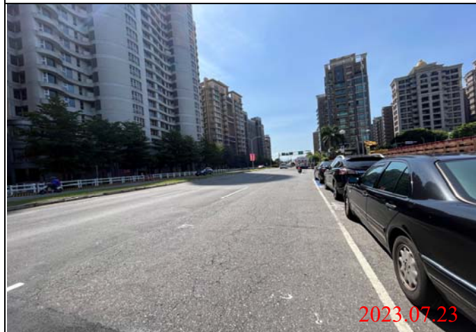
巡查日期地點：112.07.23/ Y23車站 照片說明：路面狀況
