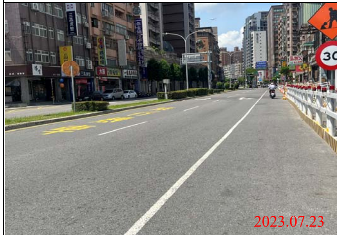
巡查日期地點：112.07.23/ Y22車站 照片說明：路面狀況
