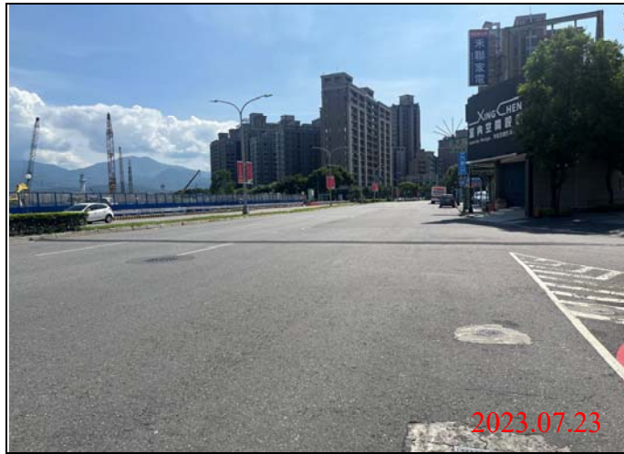
巡查日期地點：112.07.23/ Y22車站 照片說明：路面狀況
