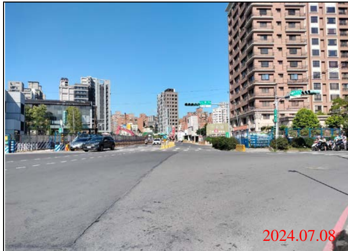
巡查日期地點：113.07.08/ Y22車站 照片說明：路面狀況
