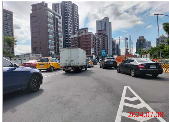
巡查日期地點：113.07.08/-23車站 照片說明：路面狀況
