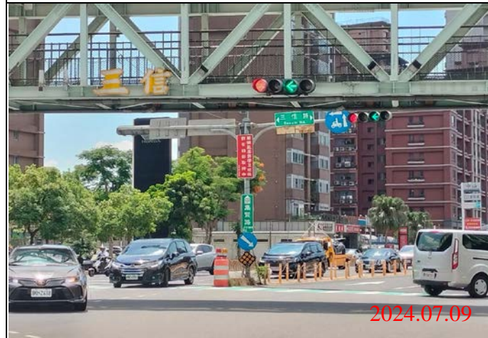
巡查日期地點：113.07.08/ Y23車站 照片說明：牌面設置狀況
