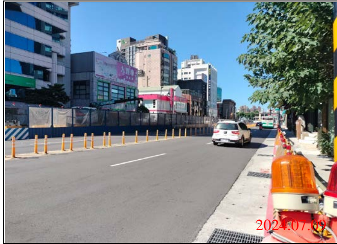
巡查日期地點：113.07.08/ Y21車站 照片說明：路面狀況
