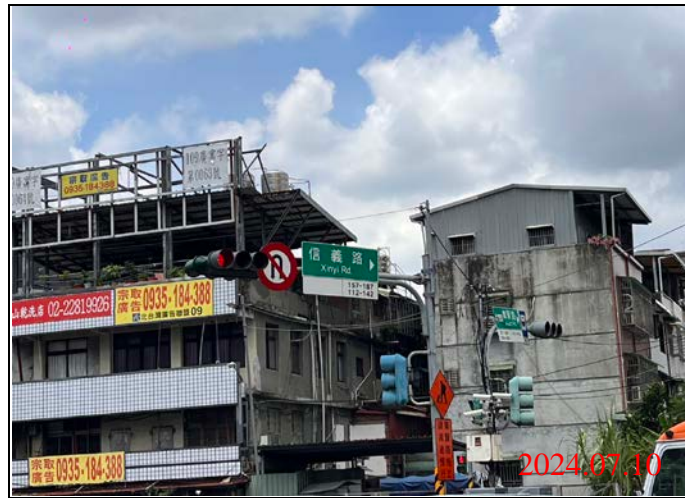
巡查日期地點：113.07.10/ Y21車站 照片說明：牌面設置狀況
