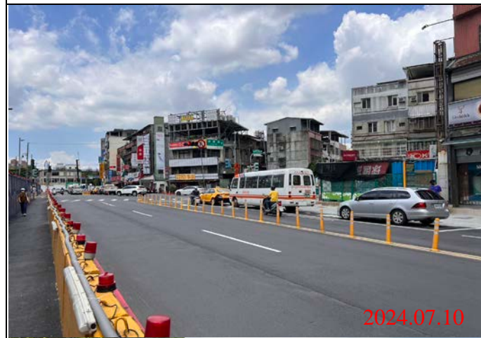
巡查日期地點：113.07.10/ Y21車站 照片說明：路面狀況
