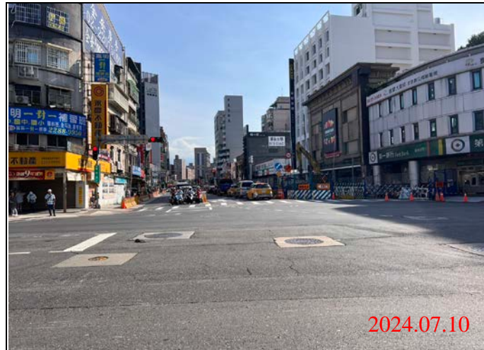
巡查日期地點：113.07.10/ Y21車站 照片說明：路面狀況
