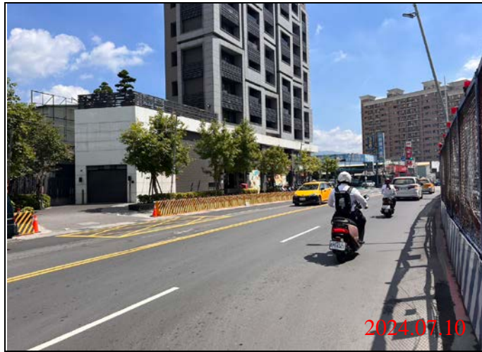
巡查日期地點：113.07.10/ Y22車站 照片說明：路面狀況
