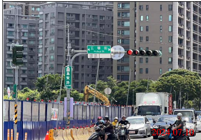
巡查日期地點：113.07.10/ Y22車站 照片說明：牌面設置狀況
