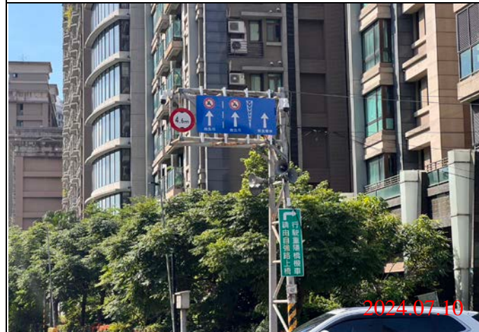
巡查日期地點：113.07.10/ Y23車站 照片說明：牌面設置狀況
