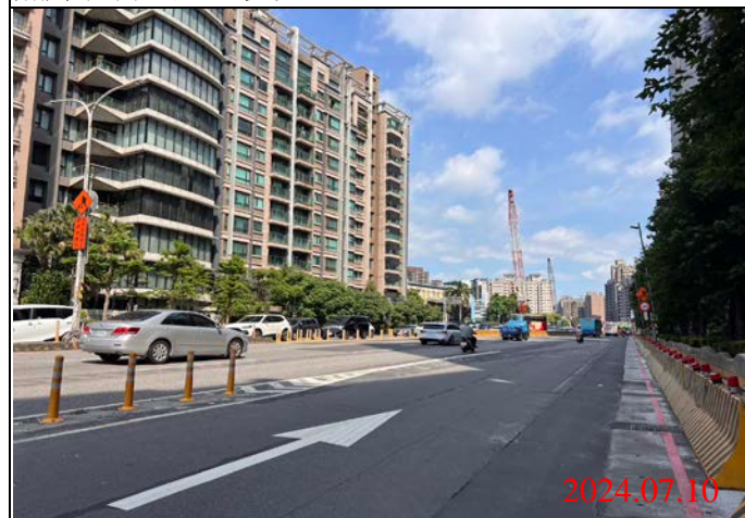
巡查日期地點：113.07.10/ Y23車站 照片說明：路面狀況
