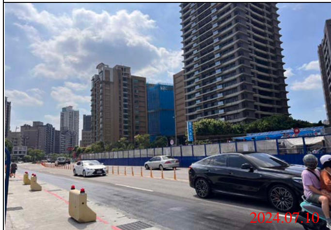
巡查日期地點：113.07.10/ Y22車站 照片說明：路面狀況
