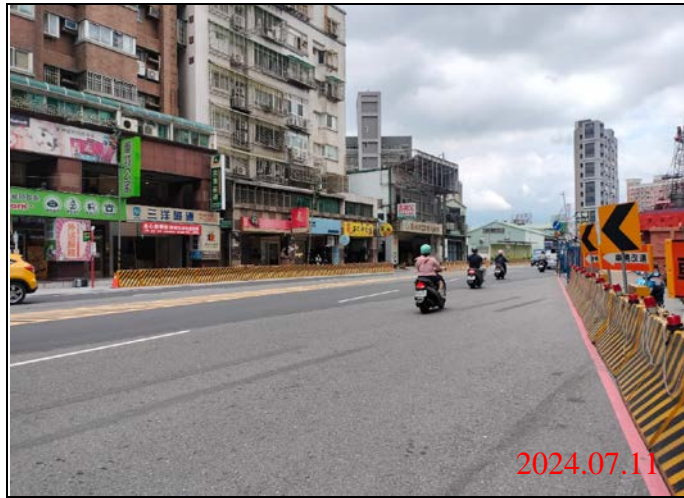
巡查日期地點：113.07.11/ Y22車站 照片說明：路面狀況
