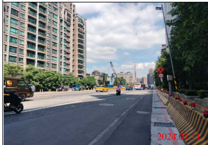
巡查日期地點：113.07.11/ Y23車站 照片說明：路面狀況
