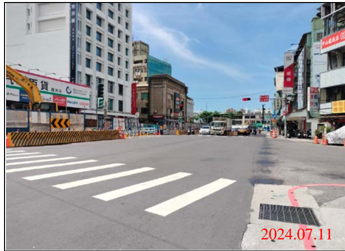
巡查日期地點：113.07.11/ Y21車站 照片說明：牌面設置狀況
