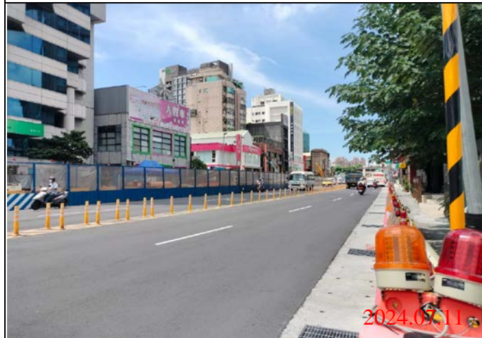
巡查日期地點：113.07.11/ Y21車站 照片說明：路面狀況
