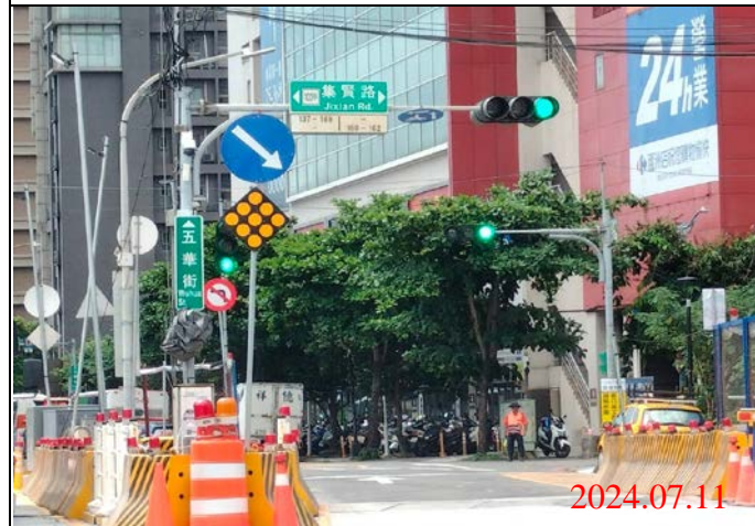
巡查日期地點：113.07.11/ Y22車站 照片說明：牌面設置狀況
