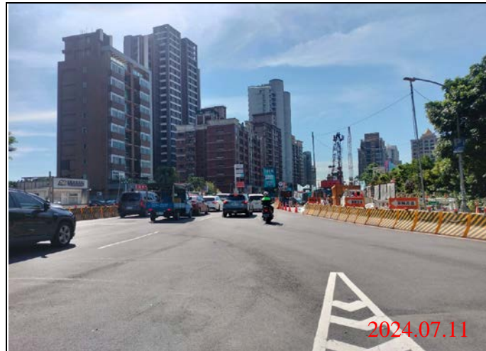
巡查日期地點：113.07.11/-23車站 照片說明：路面狀況
