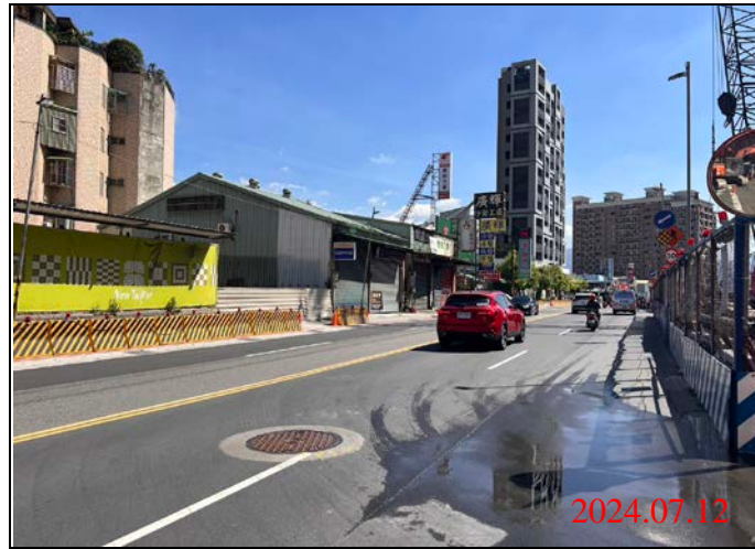
巡查日期地點：113.07.12/ Y22車站 照片說明：路面狀況
