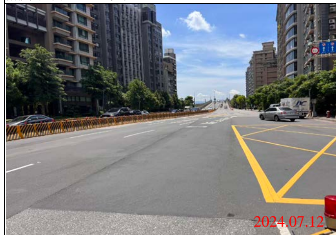
巡查日期地點：113.07.12/ Y23車站 照片說明：路面狀況
