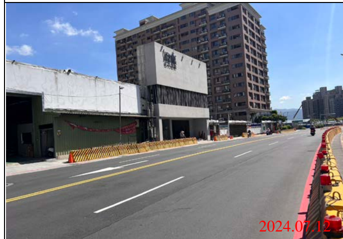
巡查日期地點：113.07.12/ Y22車站 照片說明：路面狀況
