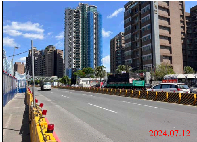
巡查日期地點：113.07.12/-23車站 照片說明：路面狀況
