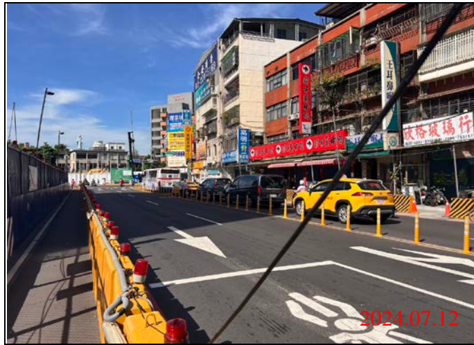
巡查日期地點：113.07.12/ Y21車站 照片說明：路面狀況
