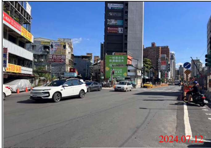
巡查日期地點：113.07.12/ Y21車站 照片說明：路面狀況
