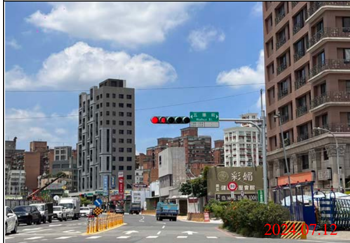
巡查日期地點：113.07.12/ Y22車站 照片說明：牌面設置狀況
