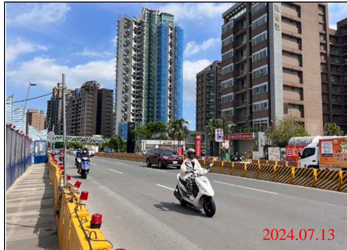
巡查日期地點：113.07.13/-23車站 照片說明：路面狀況
