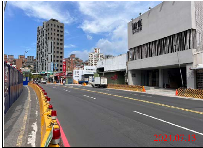
巡查日期地點：113.07.13/ Y22車站 照片說明：路面狀況
