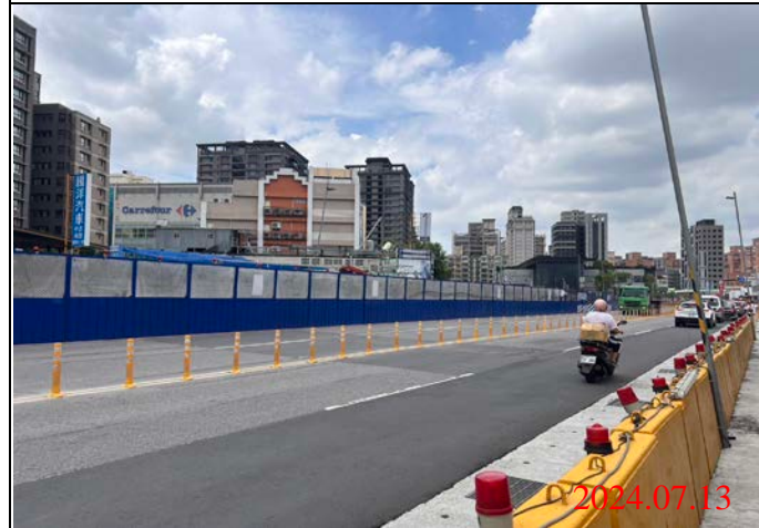
巡查日期地點：113.07.13/ Y22車站 照片說明：路面狀況
