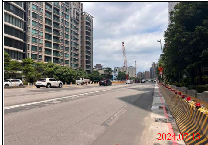
巡查日期地點：113.07.13/ Y23車站 照片說明：路面狀況
