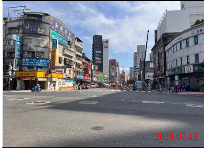
巡查日期地點：113.07.13/ Y21車站 照片說明：路面狀況
