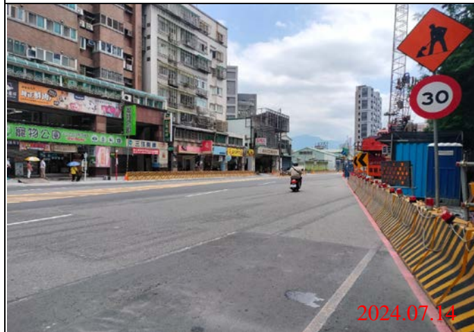
巡查日期地點：113.07.14/ Y22車站 照片說明：路面狀況
