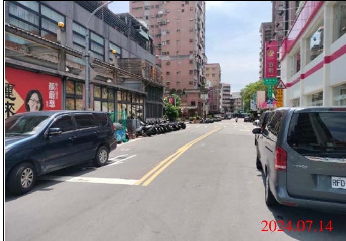
巡查日期地點：113.07.14/ Y21車站 照片說明：路面狀況
