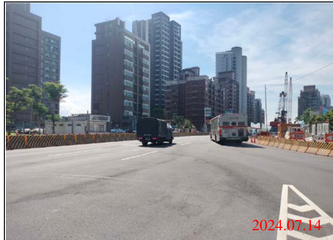
巡查日期地點：113.07.14/-23車站 照片說明：路面狀況
