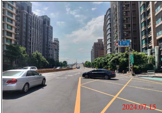
巡查日期地點：113.07.15/ Y23車站 照片說明：路面狀況
