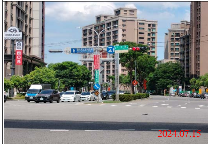
巡查日期地點：113.07.15/ Y23車站 照片說明：牌面設置狀況
