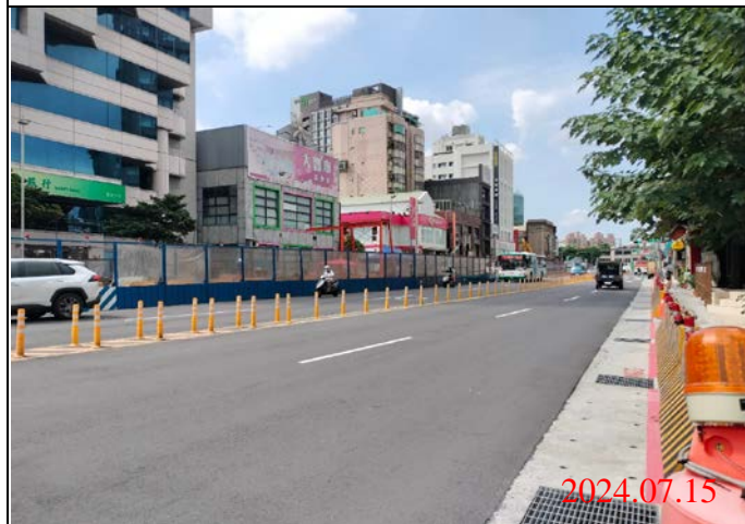
巡查日期地點：113.07.15/ Y21車站 照片說明：路面狀況
