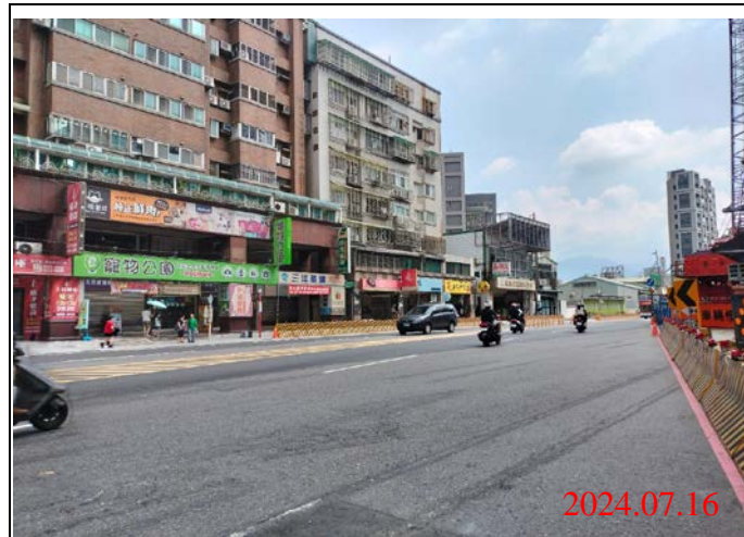
巡查日期地點：113.07.16/ Y22車站 照片說明：路面狀況
