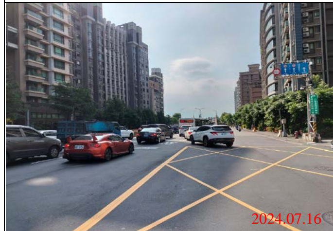
巡查日期地點：113.07.16/ Y23車站 照片說明：路面狀況
