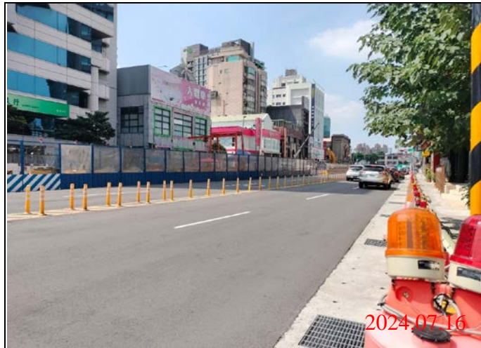
巡查日期地點：113.07.16/ Y21車站 照片說明：路面狀況
