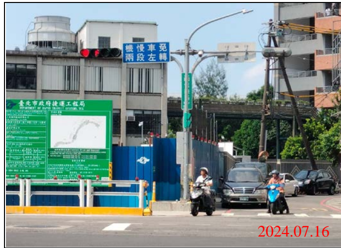
巡查日期地點：113.07.16/ Y21車站 照片說明：牌面設置狀況
