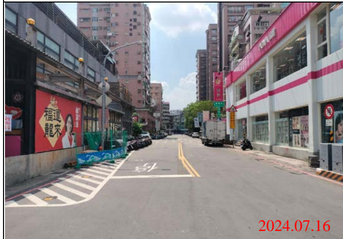
巡查日期地點：113.07.16/ Y21車站 照片說明：路面狀況
