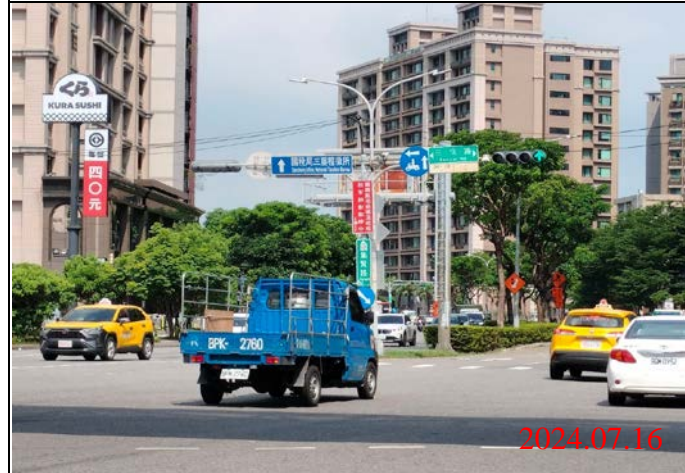
巡查日期地點：113.07.16/ Y23車站 照片說明：牌面設置狀況
