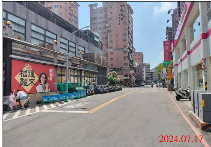
巡查日期地點：113.07.17/ Y21車站 照片說明：路面狀況
