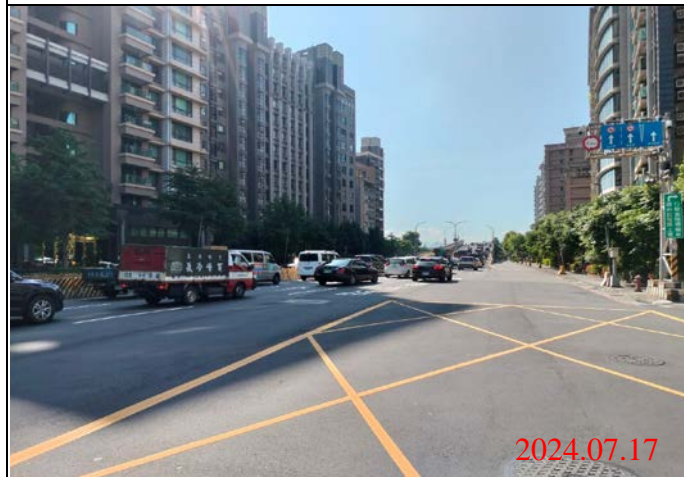
巡查日期地點：113.07.17/ Y23車站 照片說明：路面狀況
