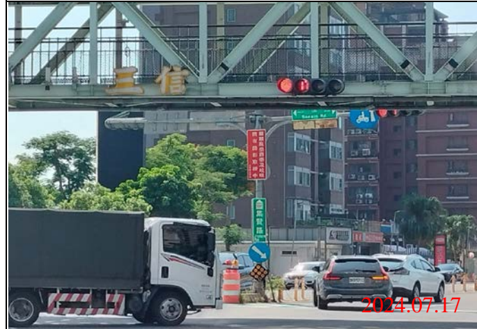
巡查日期地點：113.07.17/ Y23車站 照片說明：牌面設置狀況
