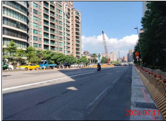
巡查日期地點：113.07.17/-23車站 照片說明：路面狀況
